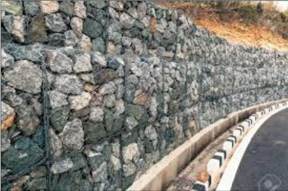
**Figura 19.** Diseño de un gabi6n, instalado a una margen de la carretera y manejo del riego.
