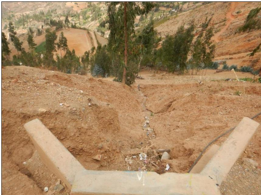
**Fotografía 10.** Se observa que la margen izquierda de la alcantarilla de concreto, está siendo erosionada, esta se encuentra en las siguientes coordenadas UTM 8990499 N, 188460E, a 3115 m s.n.m.
