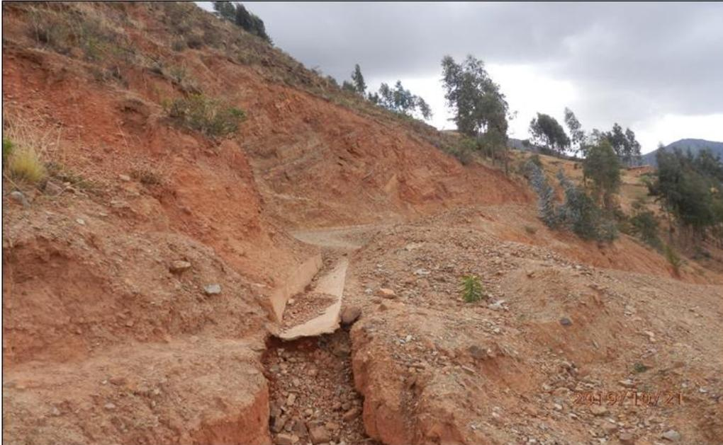
**Fotografía 8.** Se observa derrumbe, generado por corte de carretera, el evento está afectando la cuneta de concreto.
