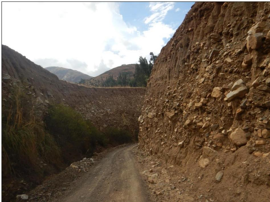
**Fotografía 7.** Vista donde se observa depósitos coluvio deluviales. Trocha de acceso al poblado de Coiroccho.
