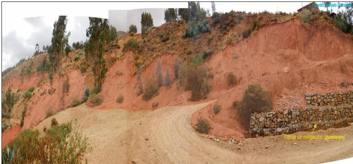
**Figura 7.** Vista al NE, en el tramo de la trocha carrozable de ingreso al centro poblado de Coirocsho, se observa gaviones como obras de mitigación para los derrumbes.
