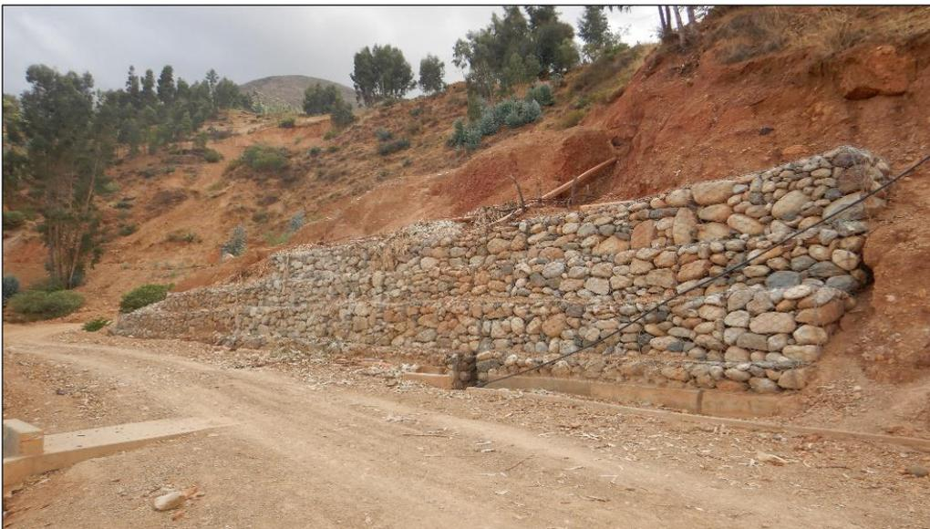
**Fotografía 9.** Gavión de 30m de longitud con altura de 3.5m, presenta canal de concreto, que vierte por la alcantarilla, aguas abajo.
