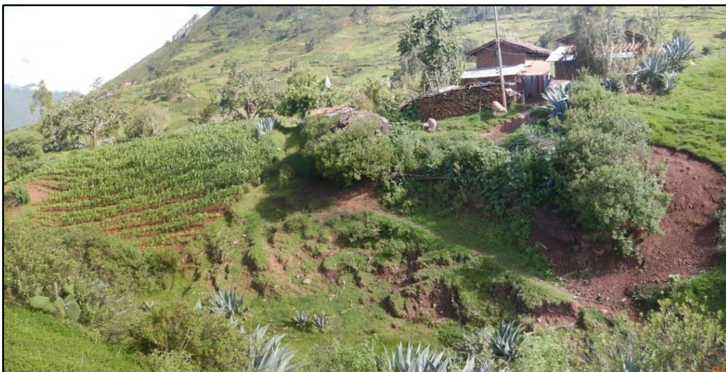
Fotografía 1. Vivienda asentada en margen derecha de la quebrada Minaspata Huayco.
