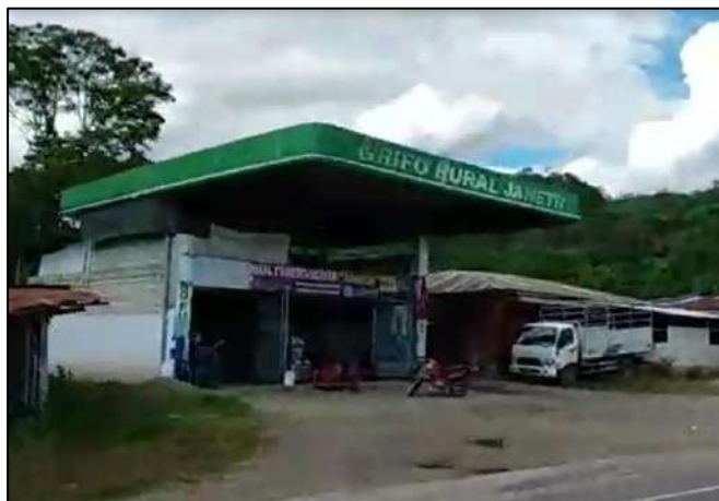
Foto 11. Grifo ubicado en Pendencia.
