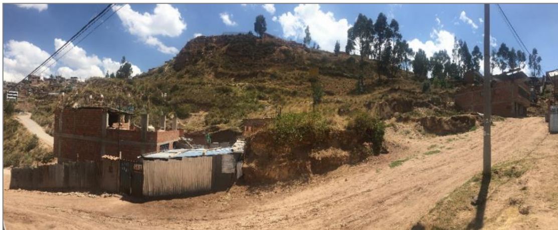
Fotografía 12. Sistema de escarpes de deslizamiento antiguos, con pendiente entre 20 y 30° y viviendas asentadas sobre el escarpe.
