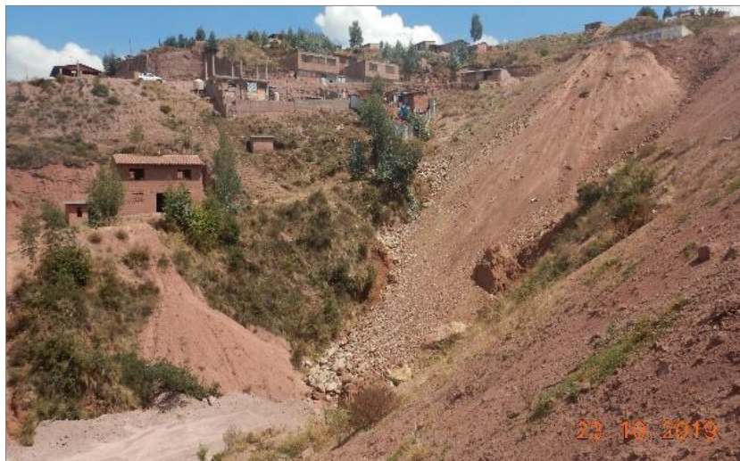
Fotografía 4. Cabecera del carcavamiento, zona de relleno.
