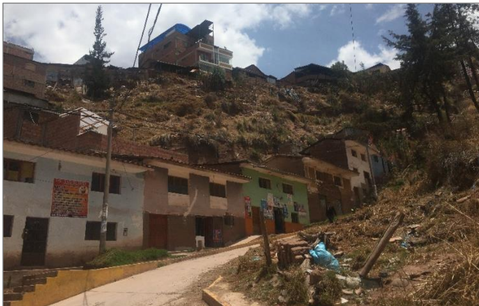
Fotografía 20. Vista de viviendas asentadas al borde del escarpe de un deslizamiento antiguo, con pendiente entre 40 y 45°.
