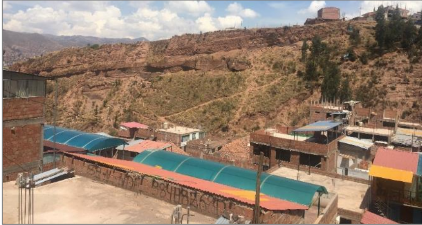
Fotografía 10. Antropización en el cauce del carcavamiento. Sistema de escarpas con pendiente entre 40-45° y con viviendas asentadas sobre el escarpe.
