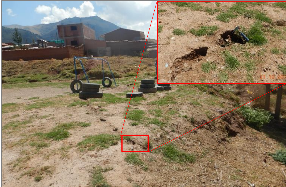
Figura 18. Corona de la cárcava, zona de relleno.
