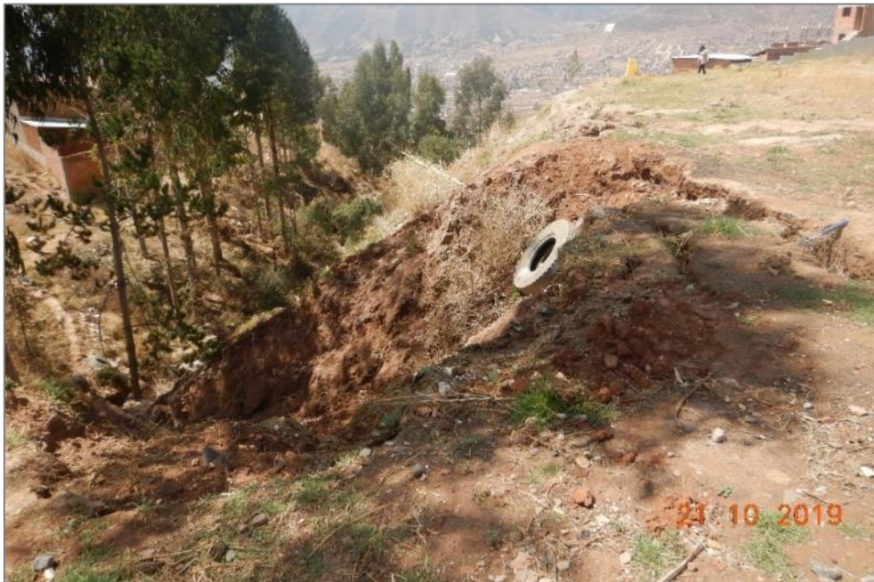
Fotografía 15. Zona de derrumbes, margen derecha de la cárcava.
