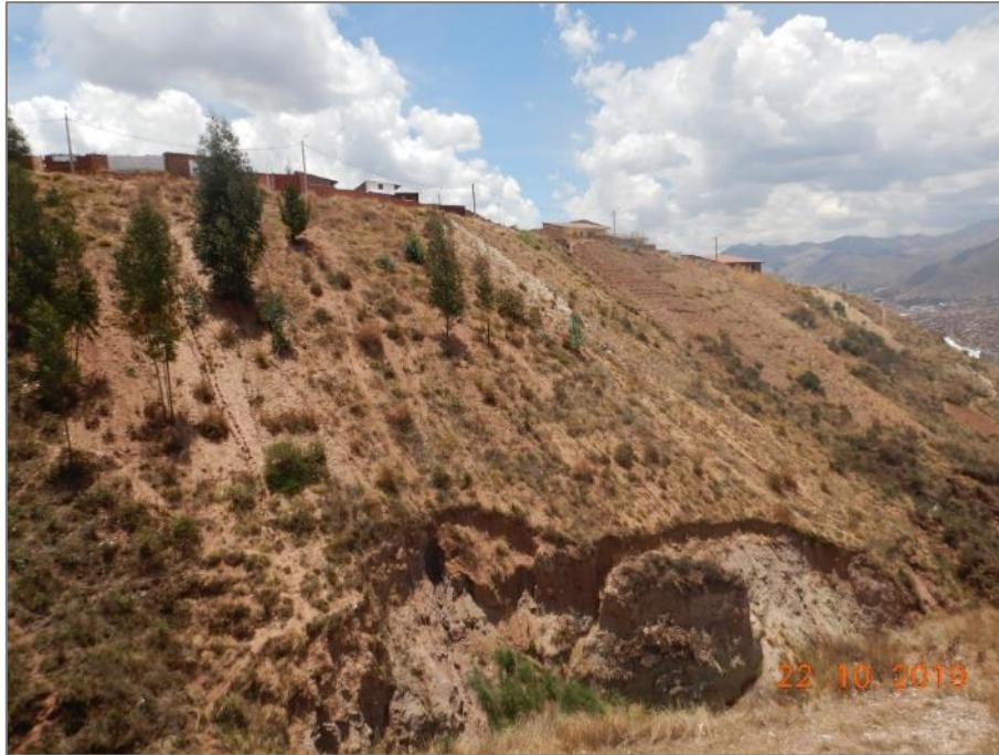
Fotografía 14. Deslizamiento activo, tipo rotacional.
