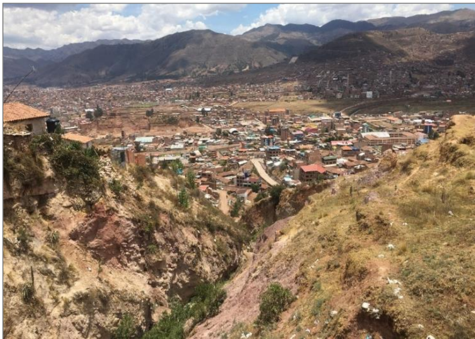
Fotografía 18. Sistema de escarpas con pendiente entre 40-45°, a 5 m se encuentra la vivienda más cercana, la zona se encuentra sin vegetación.
