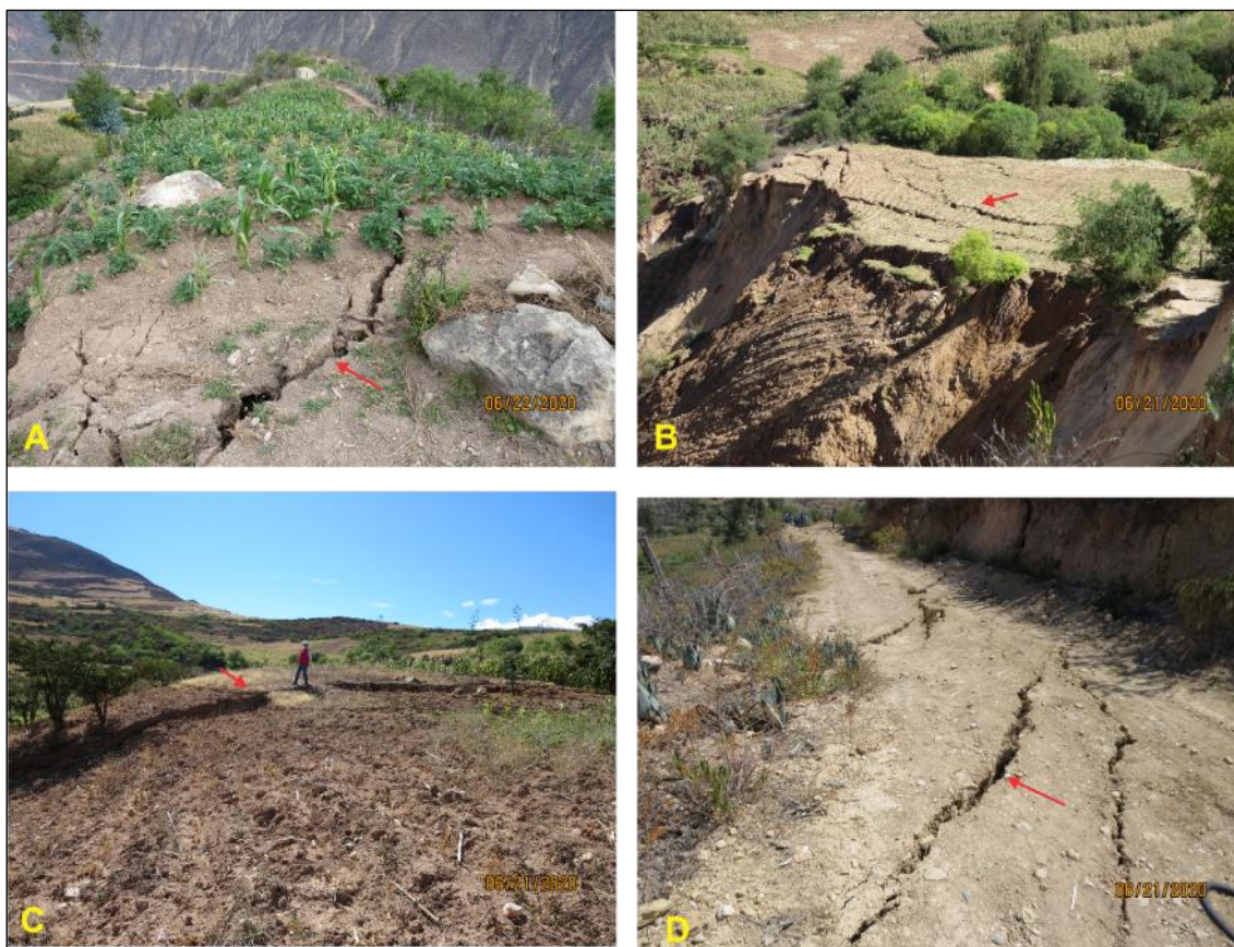
Figura 15. Vista de grietas de tracción o tensión que evidencian el avance retrogresivo del deslizamiento. A) ubicado en la cordenada UTM 277417 E – 8972865 S, grieta con longitud de 150m, apertura 0.40m y profundidad 1m; B) ubicado en la cordenada UTM 277868 E – 8972358 S, grieta con longitud de 50m, apertura 0.3m y profundidad 1m; C) ubicado en la cordenada UTM 277976 E – 897233 S, grieta con longitud 80m, apertura 0.4m, profundida 3m y salto vertical de 0.3m; y D) ubicado en la cordenada UTM 277745 E – 8972850 S, longitud de 40m, apertura 0.20m, profundidad 0.5m.
