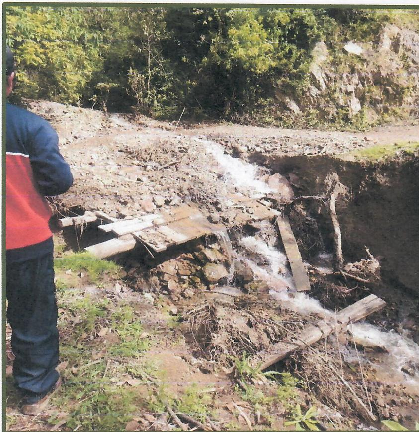
**Fotografía N° 18:** Se aprecia el primer punto crítico del colapso de una tajea o alcantarilla artesanal que la población construyó, esto a causa del incremento del caudal del río y del material de arrastre que lleva consigo; lo que provoca el bloqueo de la vía para el libre tránsito de las personas.
