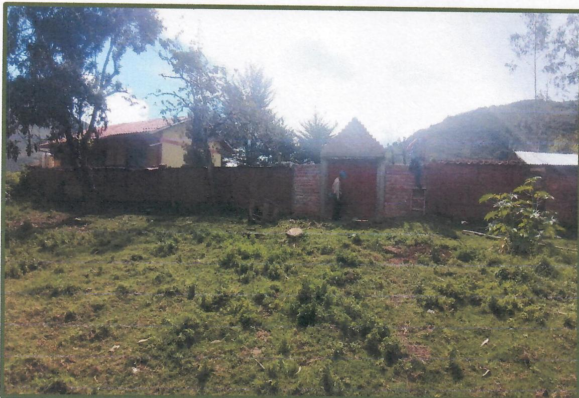
**Fotografía N° 15:** Se muestra el cerco perimétrico de la Institución Educativa de nivel Inicial Primario del Centro Poblado de Cedro, la cual se encuentra en malas condiciones (asentamiento y rajaduras en los muros de tapial y eflorescencia en los muros de ladrillo)
