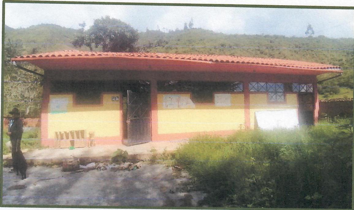
**Fotografía N° 16:** Se muestra el ambiente de la Institución Educativa de nivel Inicial Primario del C.P de Cedro, donde se presta el servicio escolar, la cual presenta pésimas condiciones en sus elementos estructurales (pandeo de la viga peraltada y rajaduras en las columnas) así mismo se observó el asentamiento del piso, humedad en los techos y paredes y rajaduras en los muros de ladrillo; por tanto la I.E.I no cuentan con las condiciones necesarias para brindar el servicio educativo.
