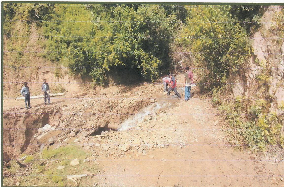
**Fotografía N° 21:** Se aprecia el tercer punto crítico del colapso de una tajea o alcantarilla artesanal que la población construyó, esto a causa del incremento del caudal del río y del material de arrastre que lleva consigo debilitando de esta manera la plataforma de la vía, provocando el bloqueo de la vía para el libre tránsito peatonal.
