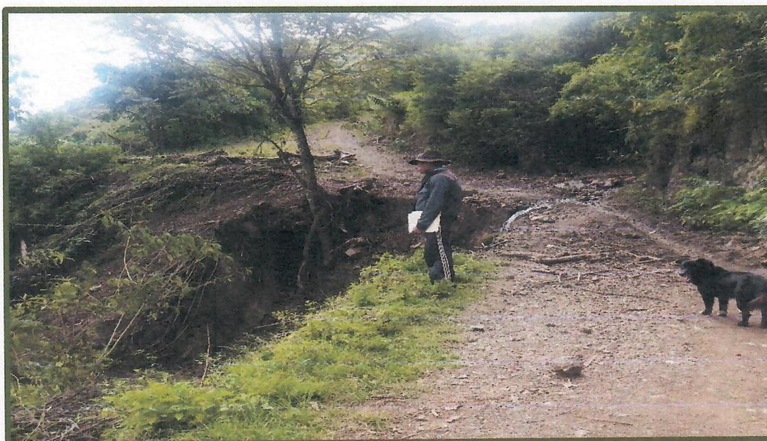
**Fotografía N° 19: Fotografía N° 20:** Se aprecia el segundo punto crítico del colapso de una tajea o alcantarilla artesanal, esto a causa del incremento del caudal del río y del material de arrastre que lleva consigo lo que debilitó la plataforma del camino de herradura provocando el bloqueo de la vía para el libre tránsito peatonal.
