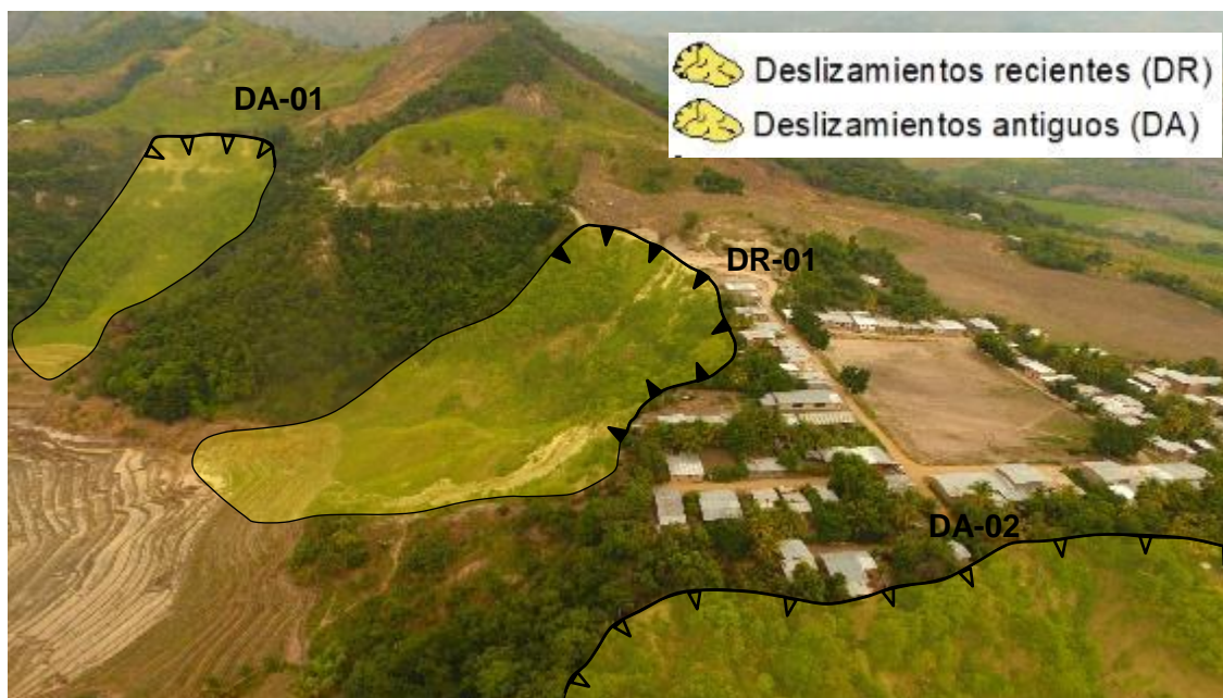
Figura 19. Vista de sur a norte del deslizamiento 01 ubicado a 760 m de la zona urbana de Colcas.
