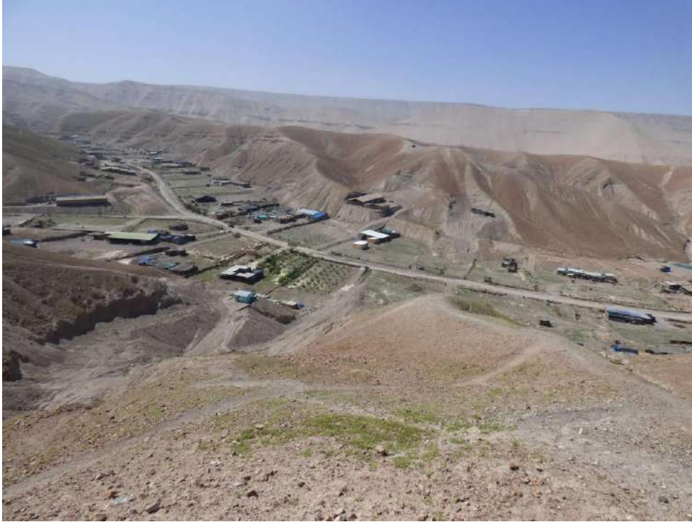
Fotografía 32: Vista con dirección al sureste donde se observa quebrada seca, cuyo curso principal ha sido ocupado por la asociación de criadores de porcinos Las Terrazas; el evento del 26 de febrero del 2020 produjo la bajada de un flujo de agua y lodo de volumen reducido, que no produjo daños considerables; sin embargo, con lluvias extraordinarias se pueden generar flujos de detritos que afectaría toda construcción realizada en el cauce.
