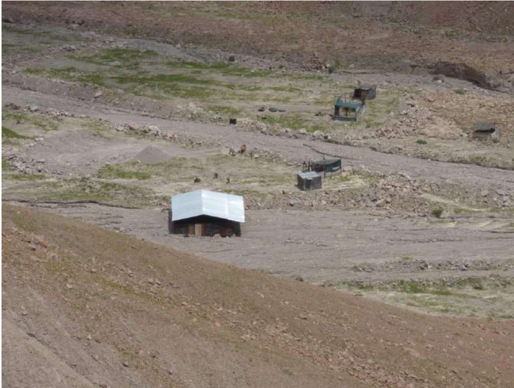
Fotografía 13: Vista con dirección al sur de uno de los tributarios de la quebrada Panteón en su cuenca media; es posible observar las huellas dejadas por el flujo de detritos (huaico) del 26 de febrero del 2020; el flujo no ocupó todo el cauce de la quebrada, pero los brazos formados afecto viviendas.
