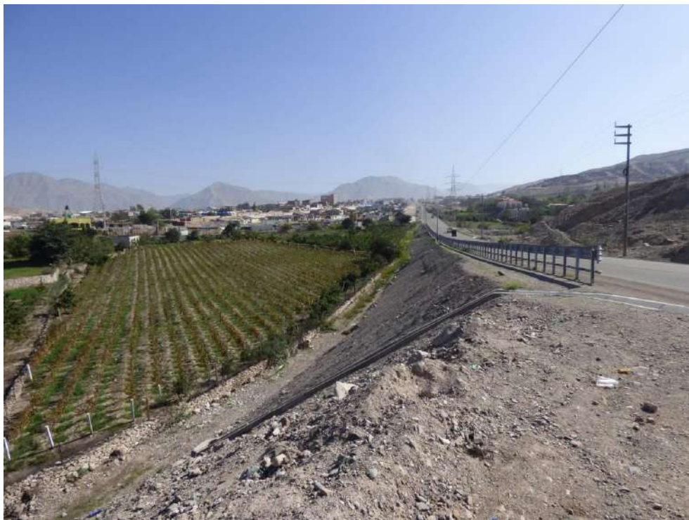
Fotografía 30: Vista con dirección al norte, se puede observar el terraplén de relleno de la carretera de acceso a la mina Toquepala (kilómetro uno), que atraviesa la quebrada seca tributaria de la quebrada Sausine.
