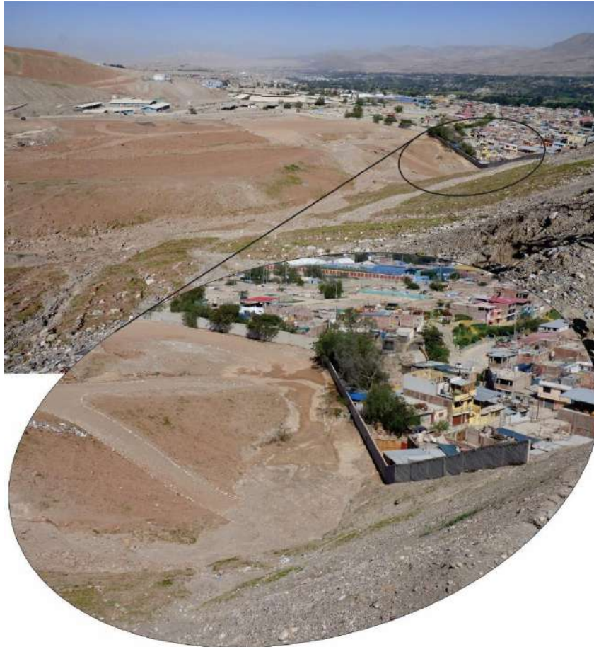
Figura 34: Vista al norte desde la cabecera de la quebrada sin nombre del muro perimétrico del cuartel Los Ángeles, aquí se observa como este muro corta la quebrada sin desfogue alguno.
