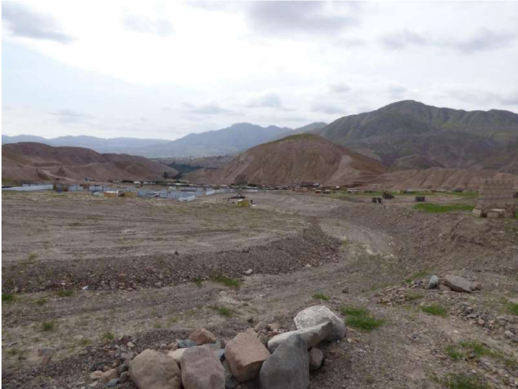
Fotografía 49: Viviendas de la Asociación de vivienda Biohuerto, Nuevo Samegua se encuentran en pleno cauce de las quebradas tributarias de la quebrada Tucuman.
