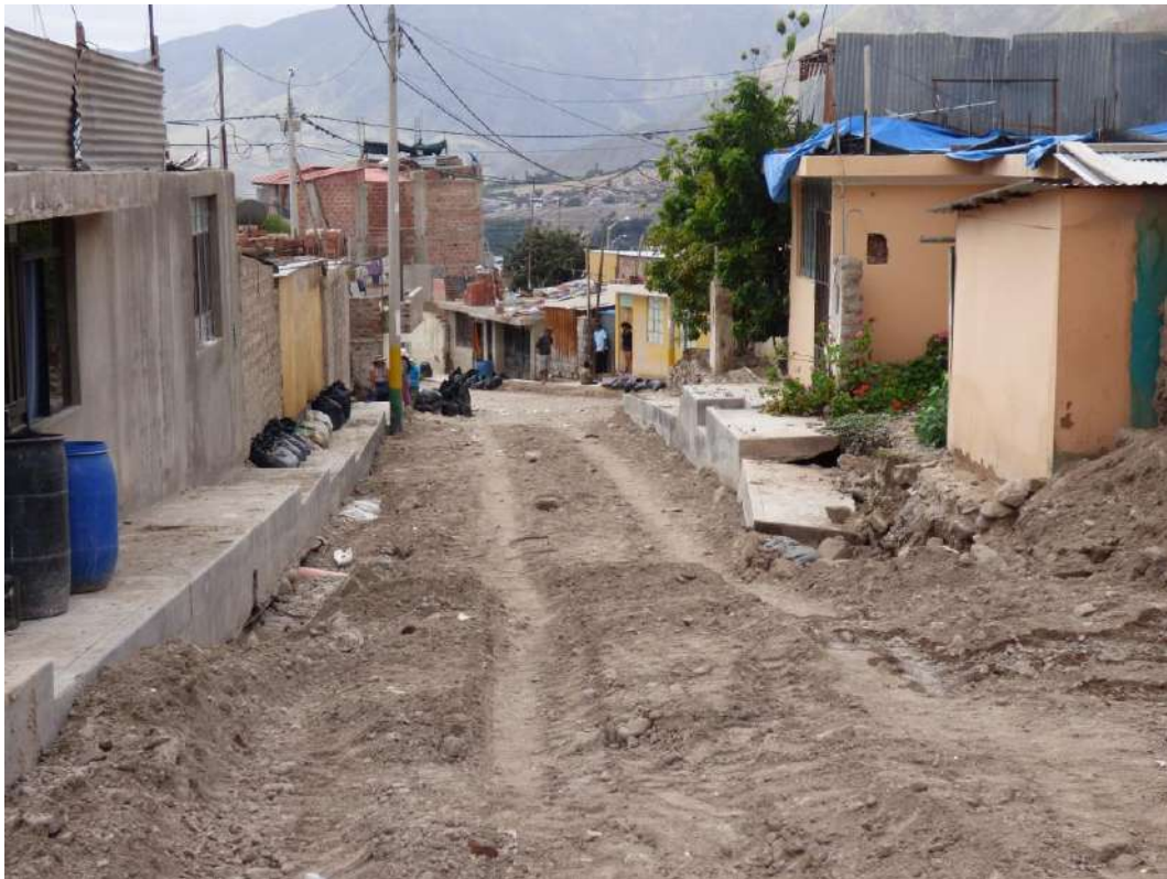
Fotografía 45: Depósito del flujo que discurrió por la calle Tahuantinsuyo, socavó las veredas de las viviendas.
