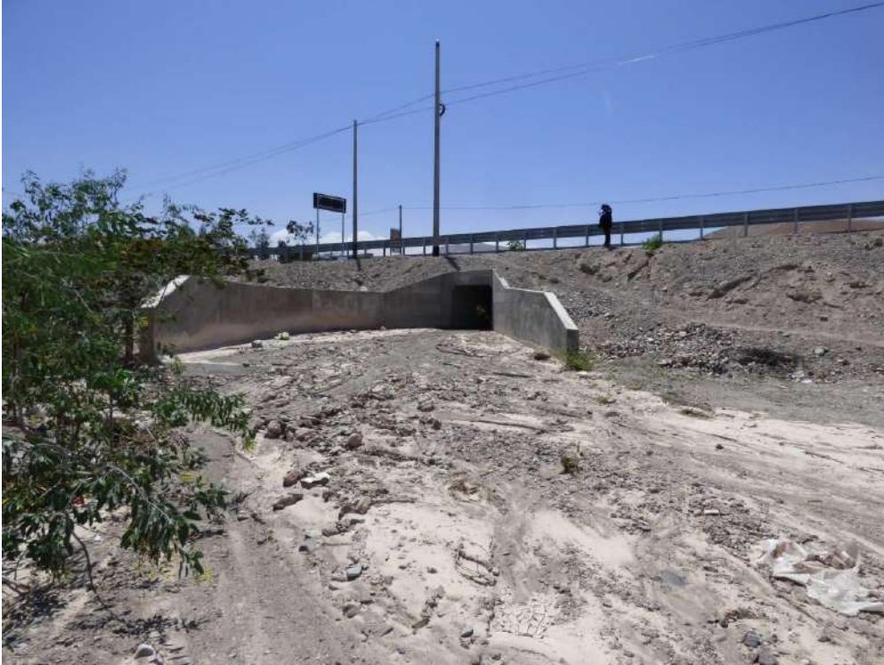
Fotografía 34: Quebrada seca atravesada por pontón en la carretera que conduce a la mina Toquepala; se observa material gravo-arenoso acarreado con el flujo de detritos (huaico) del 26 de febrero del 2020.
