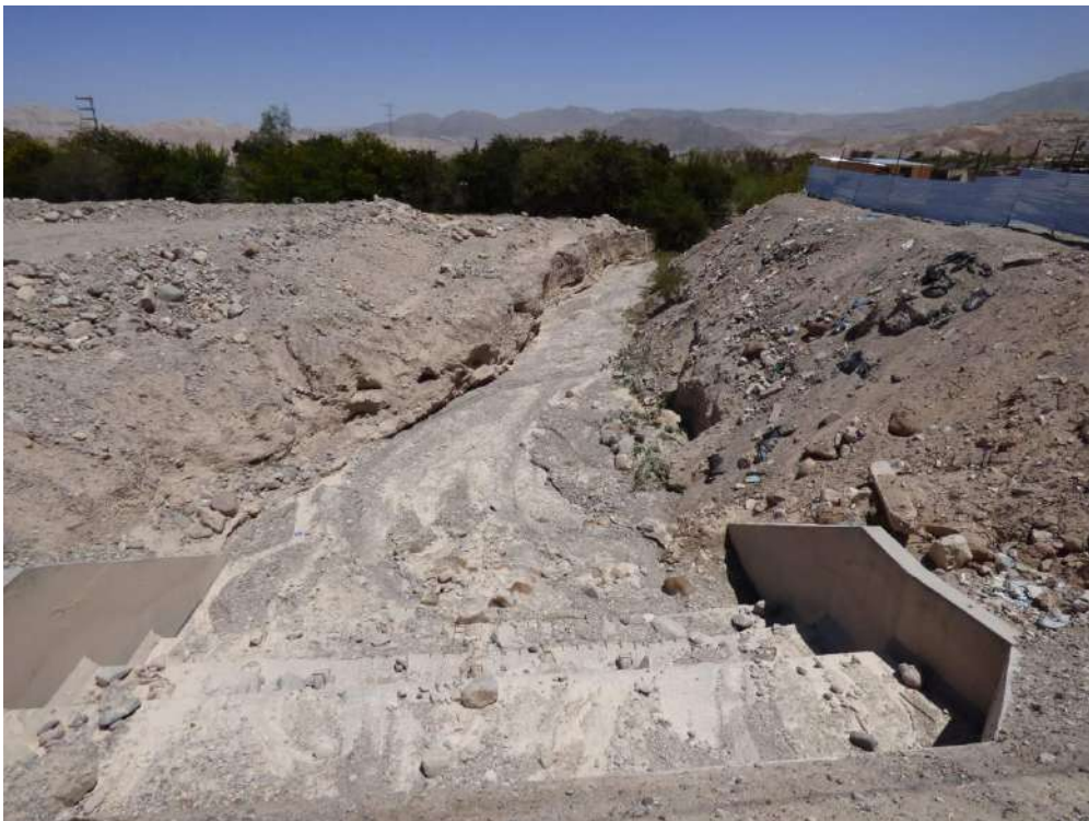
Fotografía 35: Vista aguas abajo con dirección al oeste de quebrada Sausine que atraviesa la carretera de acceso a la mina Toquepala por un pontón de concreto, el cauce de la quebrada ha sido estrechado por esta obra. En la imagen se puede observar parte del material gravo-arenoso acarreado por el flujo de detritos del 26 de febrero del 2020.
