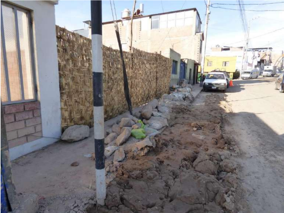
Fotografía 23: Vista con dirección al noreste, se puede observar vivienda afectada en la Av. Andrés A. Cáceres y el material areno-limoso dejado por el flujo.
