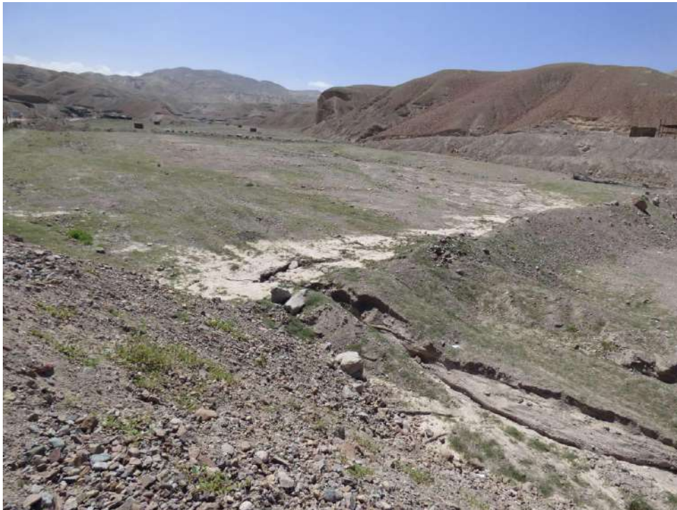
Fotografía 33: Quebrada seca sin nombre que viene siendo ocupada por viviendas y terrenos de cultivo, se construyeron diques de tierra transversales en el cauce de la quebrada como medida de prevención; en la vista se puede observar que el 26 de febrero del 2020 por la quebrada bajo un flujo de agua y lodo de volumen reducido que rompió el dique de tierra.
