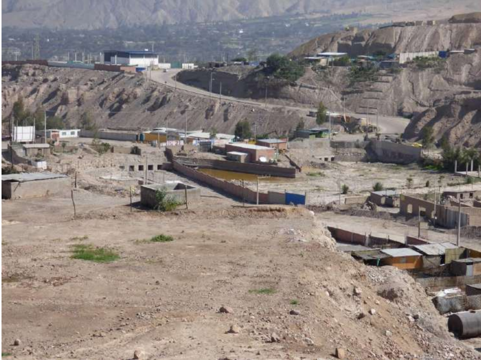
Fotografía 15: Vista con dirección al noreste, se puede observar el paso de la pista de acceso hacia la localidad de Samegua por medio de alcantarillas y terraplenes; es posible observar el anegamiento de agua formado entre el terraplén y las construcciones de ladrillos realizada dentro del cauce (color naranja).
