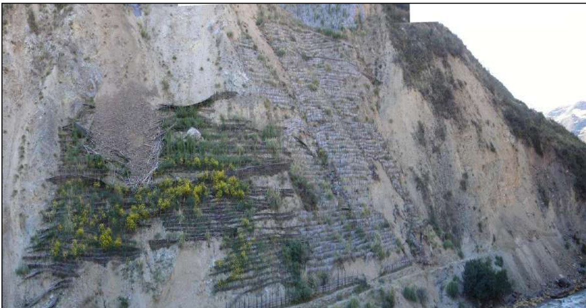
Fotografía 71: Ejemplo de evacuación de aguas superficiales y control de erosión en cárcavas, mediante trinchos escalonados.
