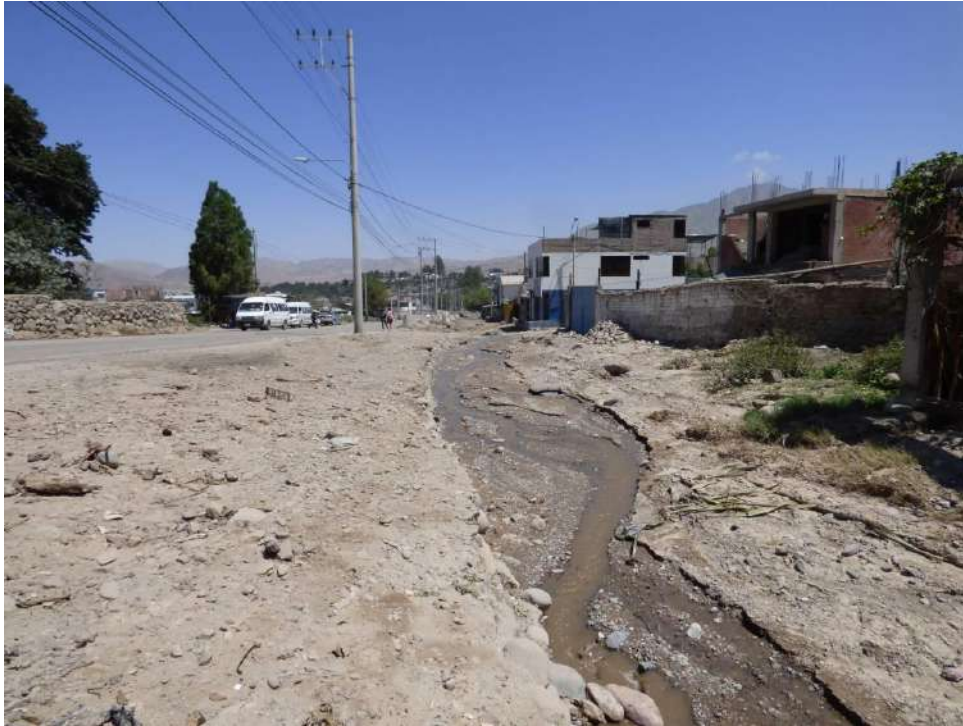
Fotografía 19: Vista con dirección al noroeste, se observa el cauce colmatado de la quebrada con material gravo arenoso, la ubicación de viviendas y la vía de evitamiento en la margen izquierda de la quebrada, muy cerca del cauce; se observa también el flujo de agua que discurre, conformado principalmente por aguas servidas y de riego.
