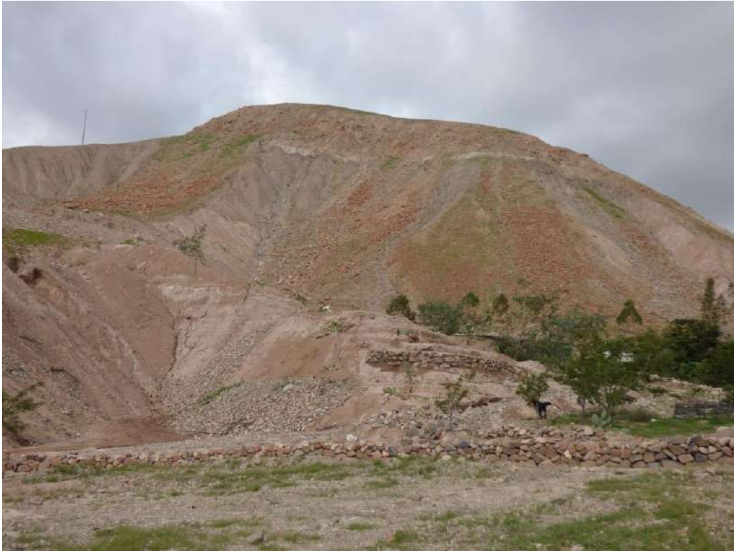
Fotografía 47: Caída de rocas y derrumbes en laderas de colinas en la Asociación de Vivienda Biohuerto.
