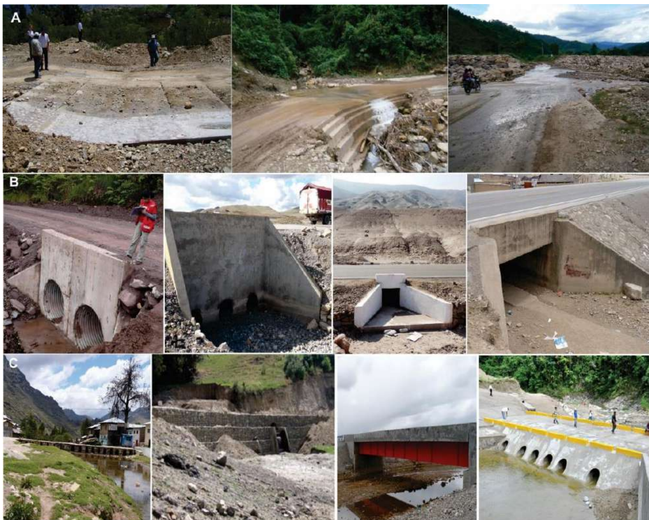
Figura 51: Obras de drenaje para redes viales, a) badenes, b) alcantarillas y pontones y c) puentes, puentes-badén
