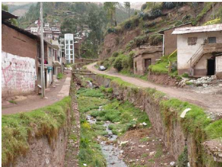
Fotografía 70: Encauzamiento de una quebrada.
