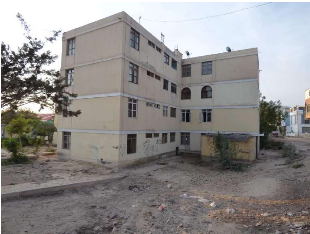
Fotografía 28: Edificio ubicado en el cruce de las avenidas Simón Bolívar y Amazonas que fue afectado por el flujo de detritos y agua; el flujo alcanzo una altura de 1 m por encima del suelo.
