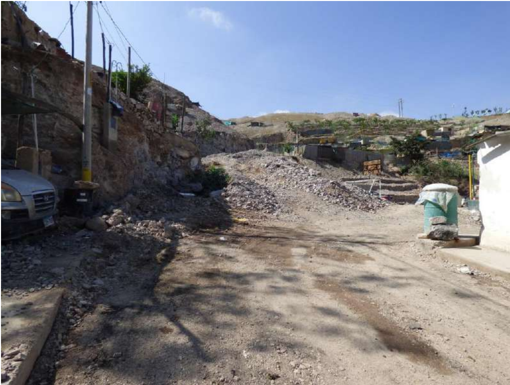
Fotografía 38: Vista del material depositado por un flujo de detritos (huaicos) que discurrió por la calle Portada, vista aguas arriba.
