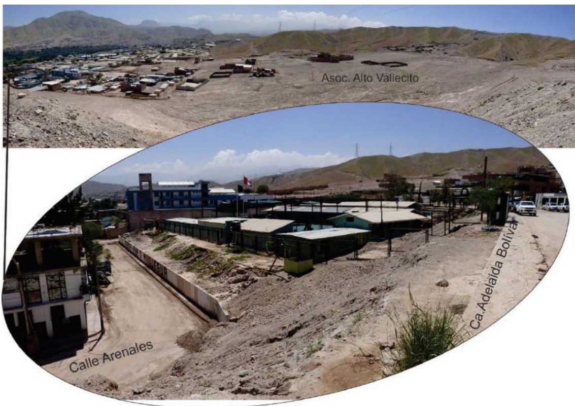
Figura 39: Vista panorámica del piedemonte aluvio-torrencial de quebrada seca sin nombre, se observan las viviendas asentadas dentro del cauce de la quebrada. En la cabecera de la quebrada presenta intensa erosión en cárcavas y surcos. En el acercamiento se observa la escuela de PNP, la cual fue muy afectada por el huaico.
