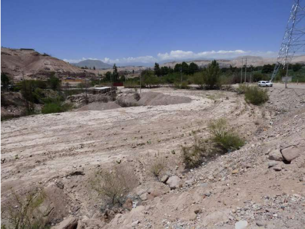
Fotografía 36: Vista con dirección al noreste, se puede observar el cauce de la quebrada Sausine en el sector de Montalvo con material gravo arenoso dejado por el flujo de detritos del 26 de febrero del 2020; que afecto una vivienda y terrenos de cultivo. Esta zona viene siendo rellenada con material de desmote con la finalidad de usarlo como terrenos para vivienda.
