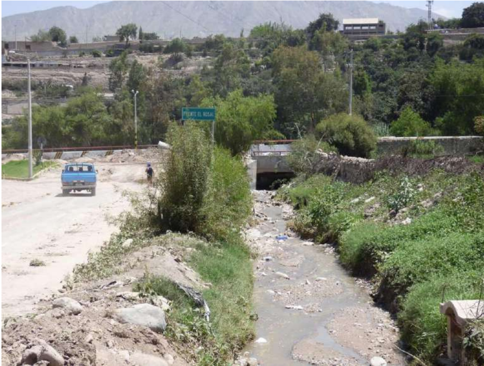
Fotografía 21: Vista aguas abajo con dirección al noroeste, se puede observar el tramo final del cauce actual de la quebrada Panteón, la cual antes de confluir al río Tumilaca atraviesa el puente El Rosal.
