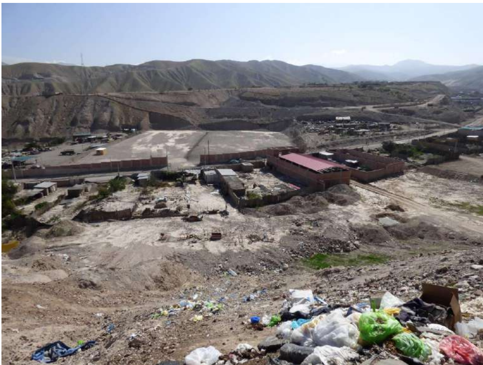
Fotografía 14: Vista con dirección al norte, se puede observar el cauce de la quebrada Panteón en la cuenca media, ocupada por viviendas y otras infraestructuras; es posible ver en color crema claro la zona afectada por el flujo de detritos del 26 de febrero del 2020.
