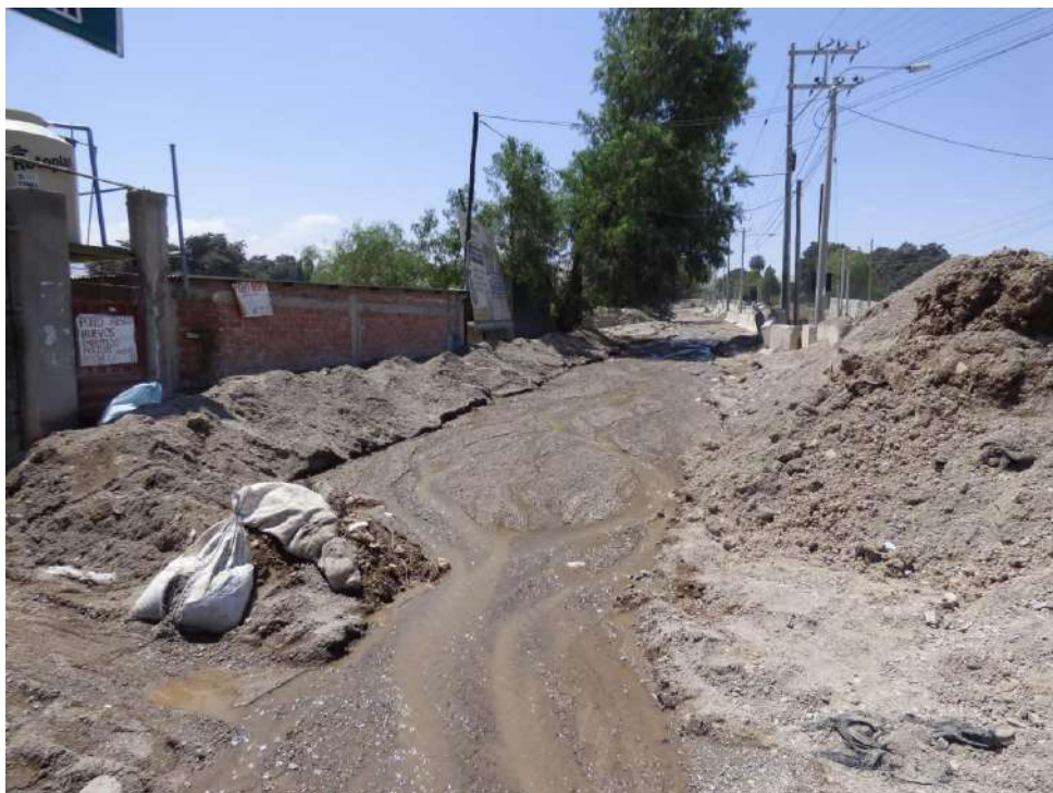
Fotografía 20: Vista aguas arriba de la quebrada Panteón con dirección al sureste, se observa el material detrítico gravo-arenoso acarreado por la quebrada, parte de este material ha sido arrimado hacia ambas márgenes del curso de la quebrada como defensas ribereñas, otro tramo del cauce de la quebrada se ha encauzado con bloques de concreto.
