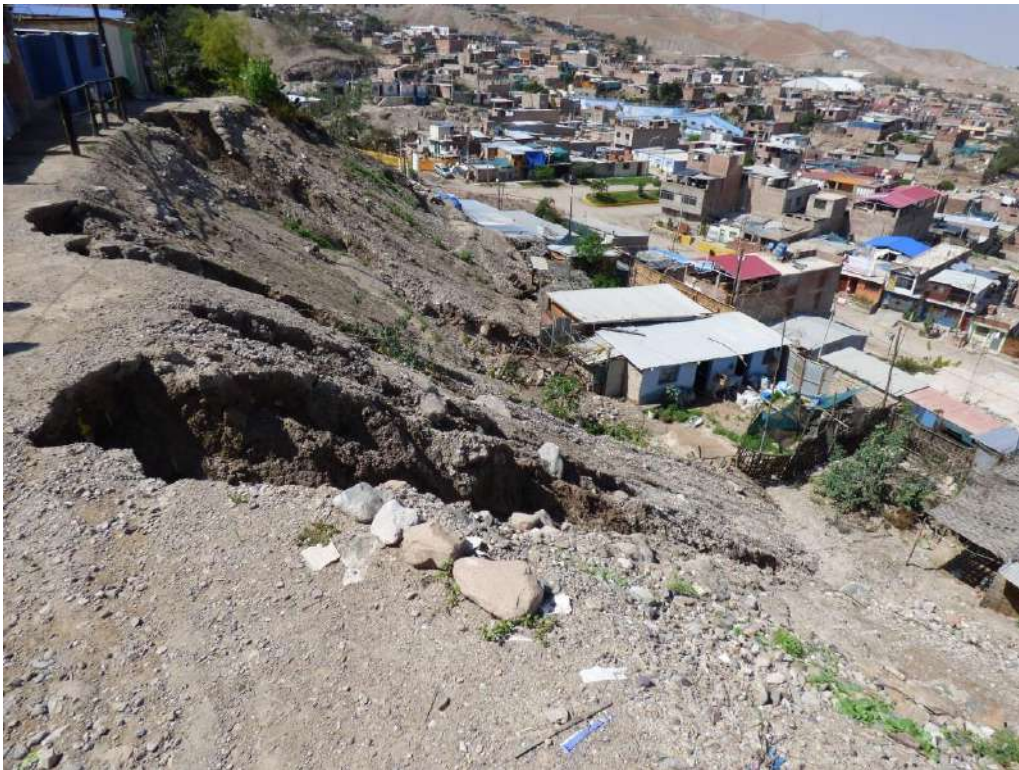
Fotografía 39: Los huaicos del 26 de febrero discurrieron a través de cárcavas, afectando viviendas que se encontraban asentadas sobre estas laderas inestables.
