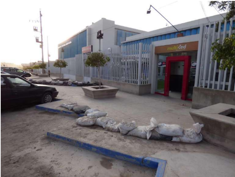
Fotografía 27: Hospital Regional de Moquegua, se puede observar los sacos térreos colocados para evitar el ingreso de agua y material sólido. También es posible ver restos del material acarreado por el flujo, conformado principalmente por arenas y limos.
