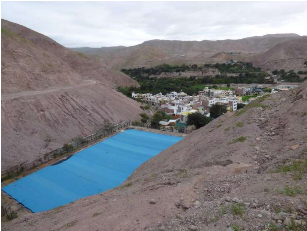
Fotografía 12: Vista aguas abajo en dirección al sur, se observa el reservorio de agua construido en el cauce de la quebrada; en el cono deluvial de la quebrada se asienta la Urbanización Country Club Villa.
