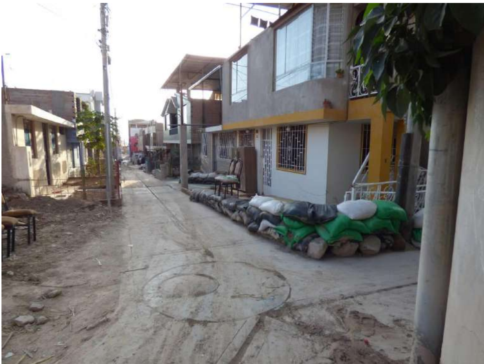
Fotografía 26: Villa Hospitalaria, es posible ver parte del material dejado por el flujo, así como las defensas con sacos térreos colocados en las viviendas para evitar el ingreso del agua y material sólido.
