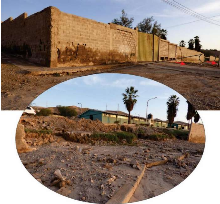
Figura 36: Muro del cuartel Los Ángeles colapsado por el empuje del flujo cerca del Instituto José Carlos Mariátegui.
