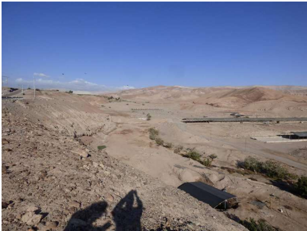
Fotografía 37: Vista aguas arriba de la quebrada San Antonio, con dirección al sureste, se observa el ancho cauce que se encuentra seco, el material gravo arenoso en el cauce y la ocupación del mismo con granjas de pollos.
