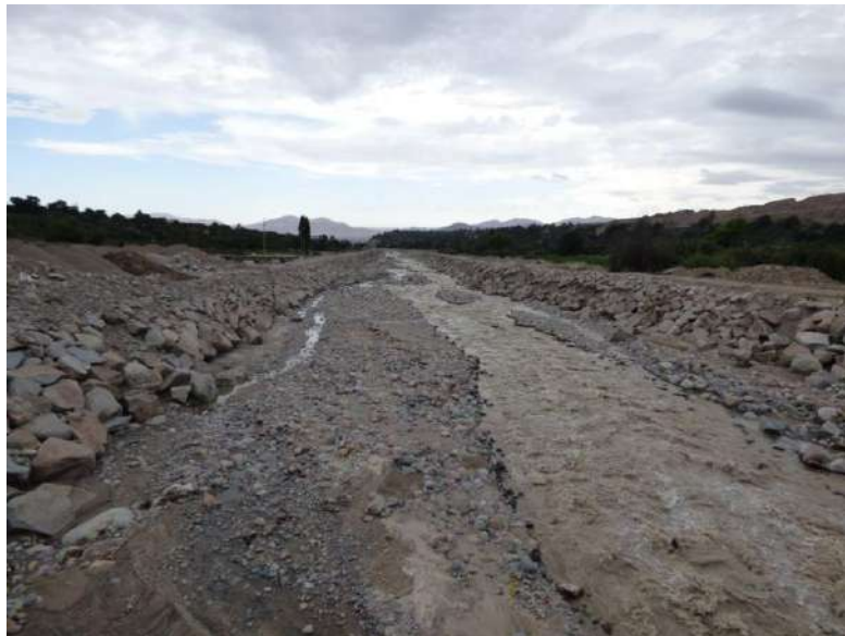
Fotografía 5: Vista con dirección al oeste, donde se observa el cauce activo del río Tumilaca, encauzado con arrimado de material y enrocados, hacia ambas márgenes se alcanza a ver parte de la llanura inundable y terrazas aluviales.
