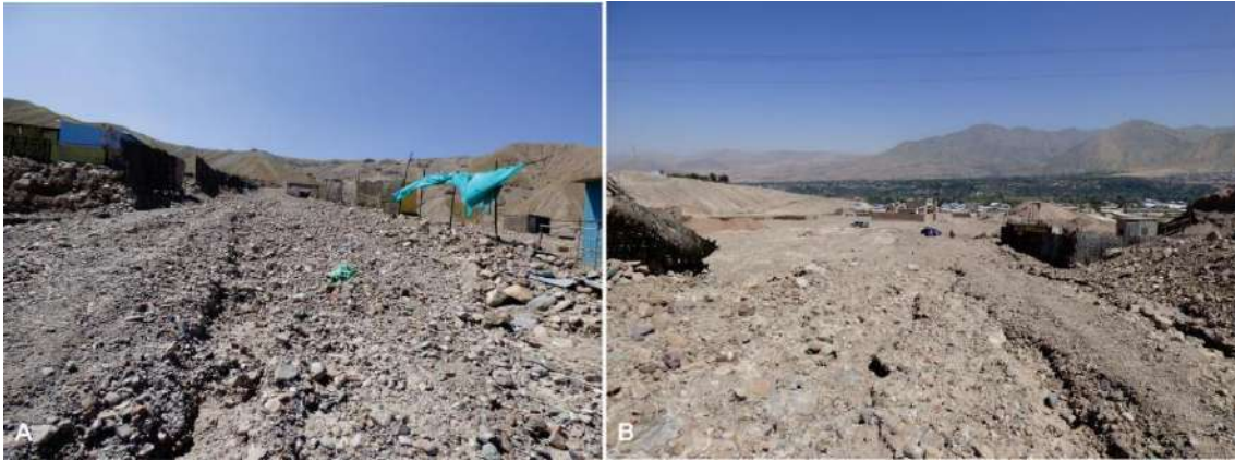
Figura 38: Viviendas de la Asociación Alto Vallecito asentado sobre piedemonte aluvio-torrencial, debido a intensas lluvias se generó huaico en esta quebrada seca afectando viviendas precarias.
