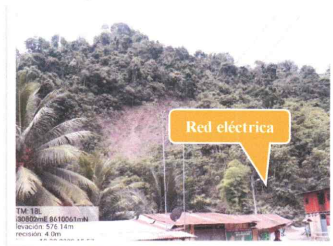
Imagen N° 2.6: Red de tendido eléctrico
