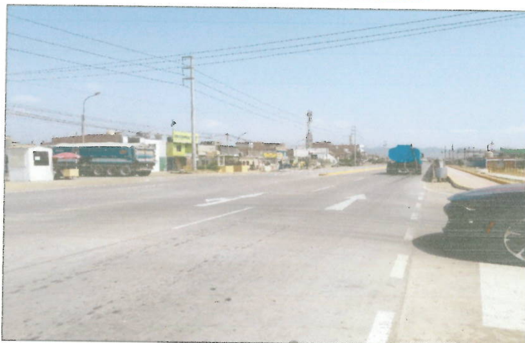
Figura 8: Vista de Antigua Carretera Panamericana sur
