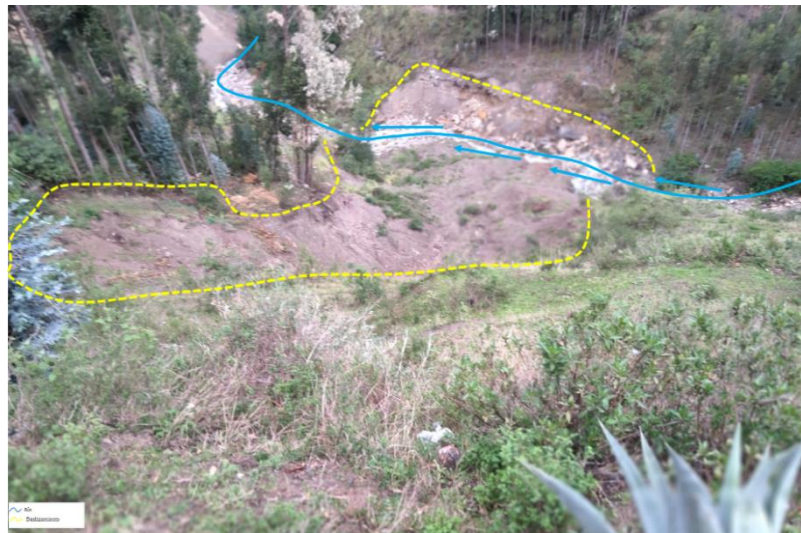
Imagen N° 11: Inestabilidad de la base de la infraestructura del centro de salud en Challhuayaco
