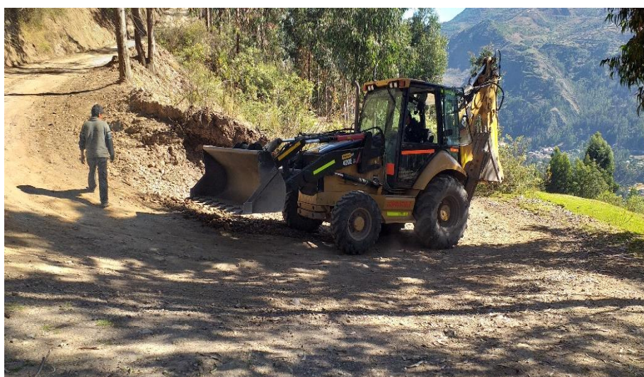
Imagen N° 34: Limpieza de material suelto en la vía que conecta al anexo de Chuchupampa
