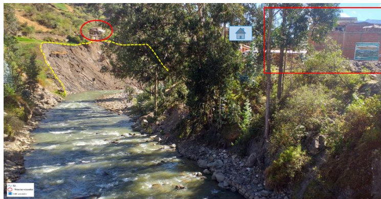
Imagen N° 19: Derrumbes e inestabilidad en el barrio de Chacuayonga
