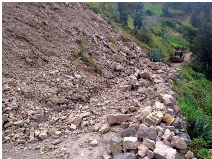
Imagen N° 29: Deslizamiento del cerro en el caserío de Tupec
