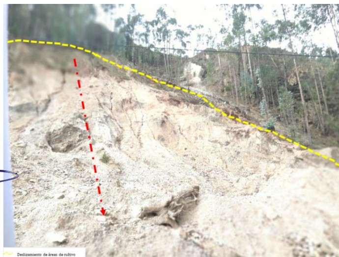
Imagen N° 17: Deslizamiento cerca de la institución educativa N° 86385
