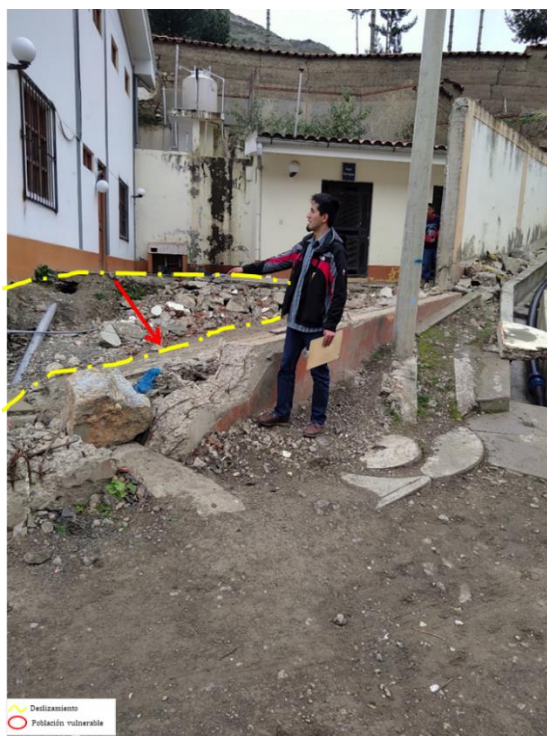
Imagen N° 11: Inestabilidad de la base de la infraestructura del centro de salud en Challhuayaco
