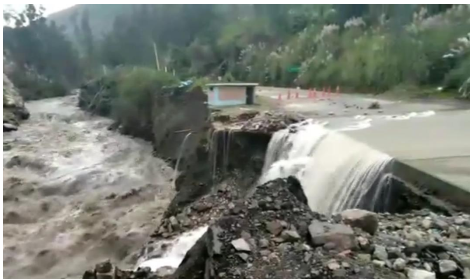
Imagen N° 37: Afectación de la captación de sistema de abastecimiento de agua por las lluvias intensas.
