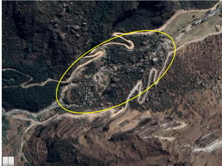
Imagen N° 35: Inundación por la filtración de agua del canal de Mosna.
