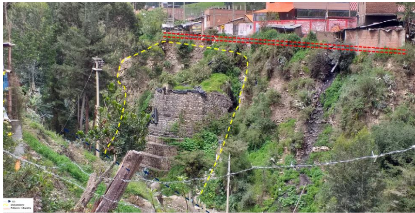
Imagen N° 12: Inestabilidad de la terraza fluvial en la base del barrio de La Florida
