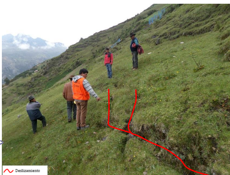
Imagen N° 1: Deslizamiento del terreno, encima del centro poblado de Putaca
