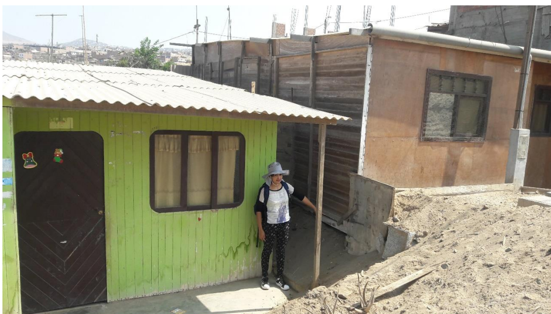
Viviendas de material precario, no tienen cimentación
