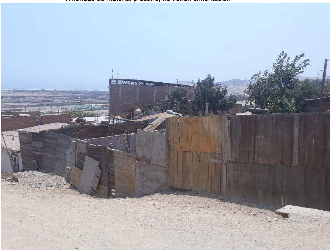
Viviendas construidas sin control técnico, al fondo se observa una construcción de material noble que no tiene continuidad de sus elementos estructurales verticales (columnas), éste que frente a un sismo de gran magnitud colapsaría.
