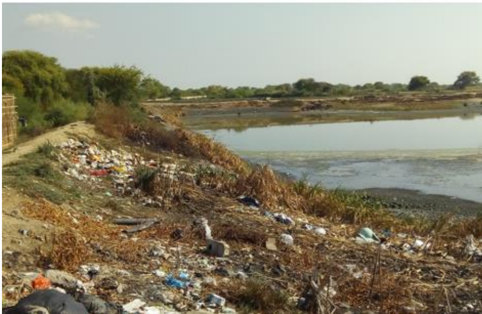
Figura 28: Pozas de oxidación que se encuentran situadas en el sector Juan de Mori, las mismas que no tienen mantenimiento que, en caso de lluvias extraordinarias superan su capacidad y se desbordan afectando áreas agrícolas y viviendas del sector.
