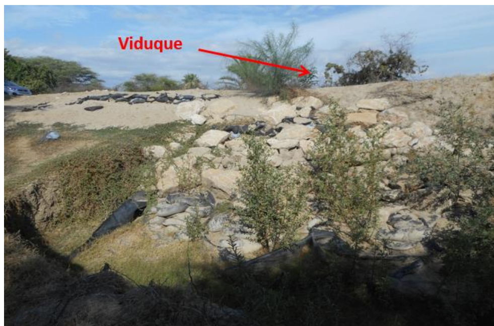
Figura 17: Sector Viduque en el cual existe una zona de ruptura de dique. En este sector se desbordó el río Piura afectando a las viviendas y áreas agrícolas de la población.
