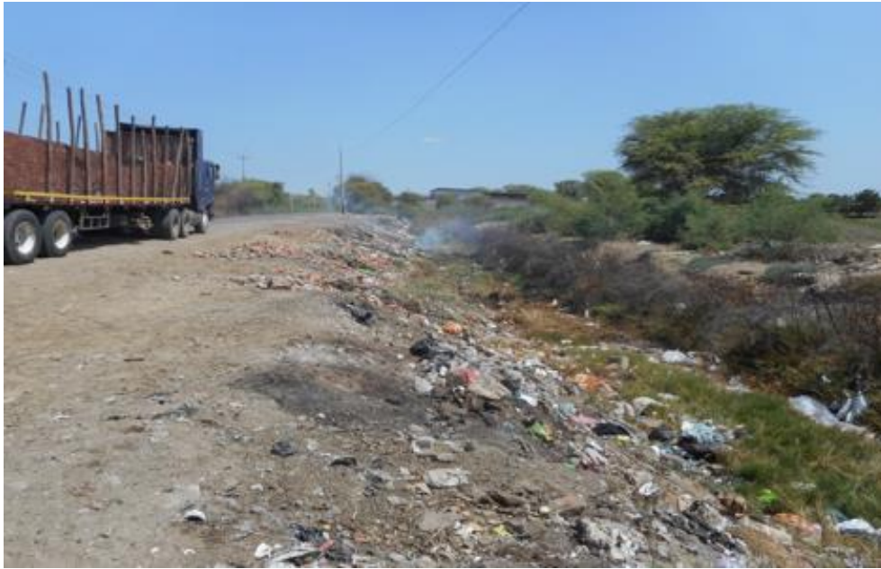
Figura 27: Acumulación de desechos antrópicos en el dren situado en el sector de Monte Sullón. La falta de mantenimiento de estos drenes no deja que las aguas sigan su curso, aumentando la posibilidad de supere su capacidad y se desborde afectando las áreas agrícolas del sector y algunas viviendas.
