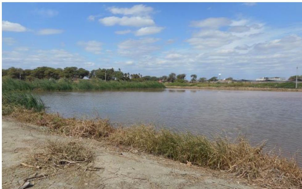
Figura 22: Pozas de Oxidación que se sitúan a espaldas del hospital privado en el sector de Simbila, en época de lluvias extraordinarias superan su capacidad y se desborda, afectando las zonas aledañas.
