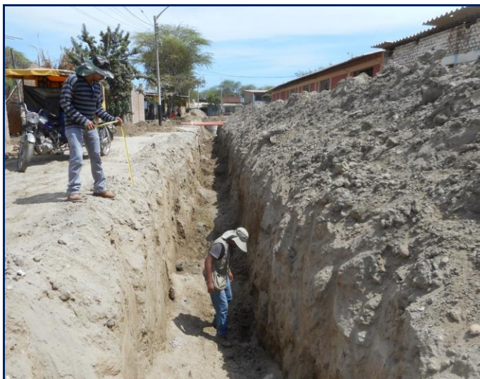
Figura 12: Depósitos aluviales constituidos por arenas de grano fino con limos. Sobre estos depósitos se encuentra asentada la ciudad de Catacaos y alrededores.
