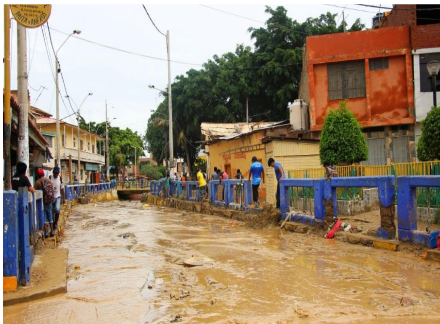
Figura 19: Quebrada Zanjón, lluvias febrero-marzo 2017 (Fuente: Ralph Zapata).
