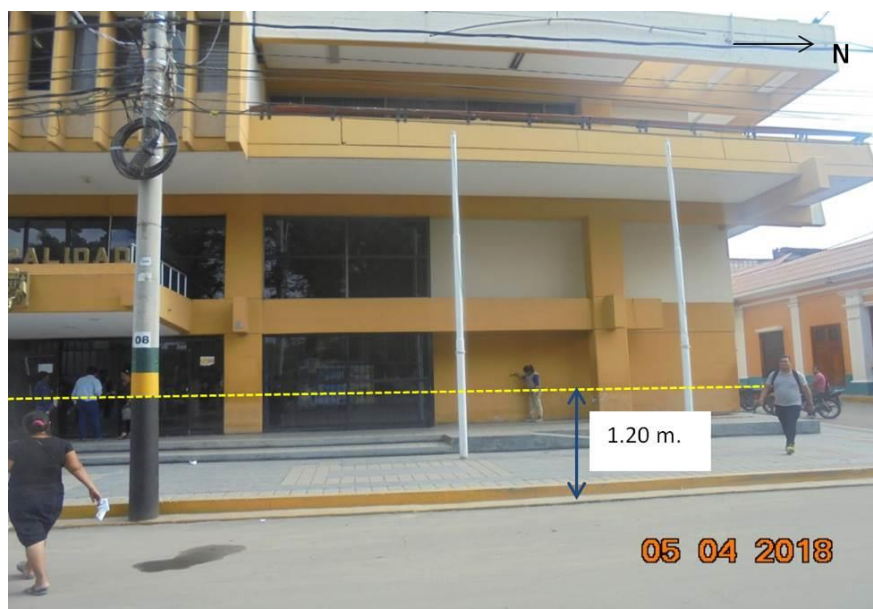
Figura 22: Nivel de inundación fluvial 2017 (1.20 m. con respecto a la calzada), registrada en el frontis de la pared de la municipalidad provincial de Piura (línea amarilla).
