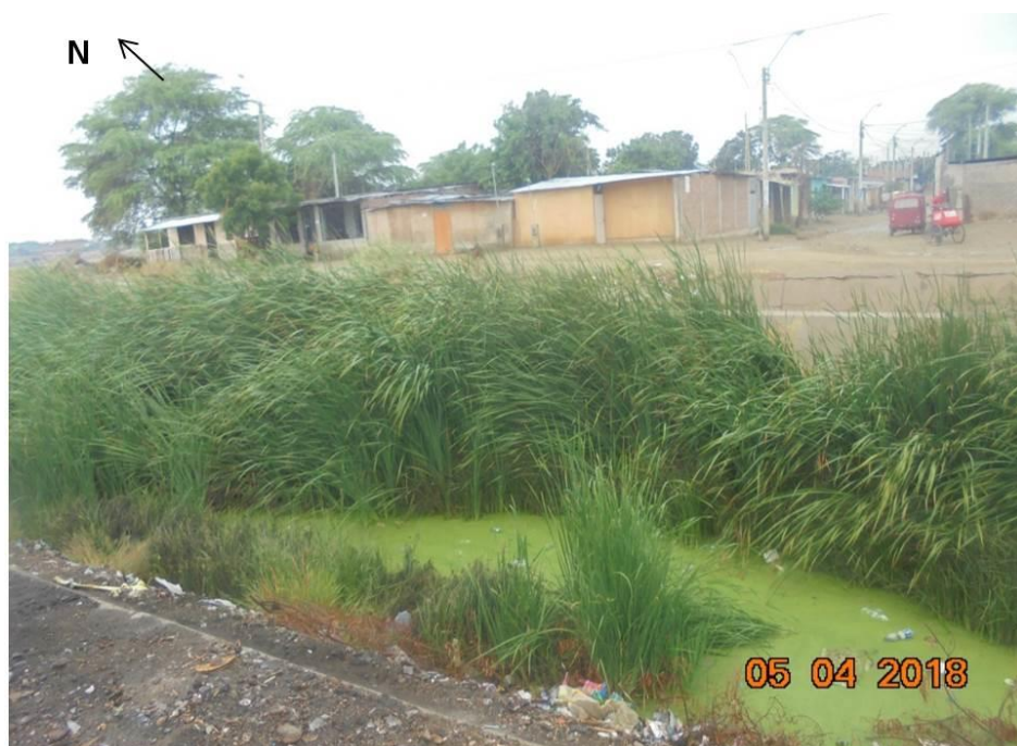
Figura 34: Aguas estancadas en el cauce del dren ubicado en el A.H. Manuel Escorza.
