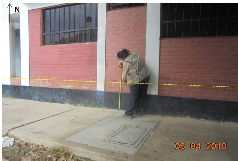
Figura 24: Calle Lima - I.E. Proyecto Pontificio, el nivel de inundación alcanzó de 1.00 m. con respecto a la acera.
