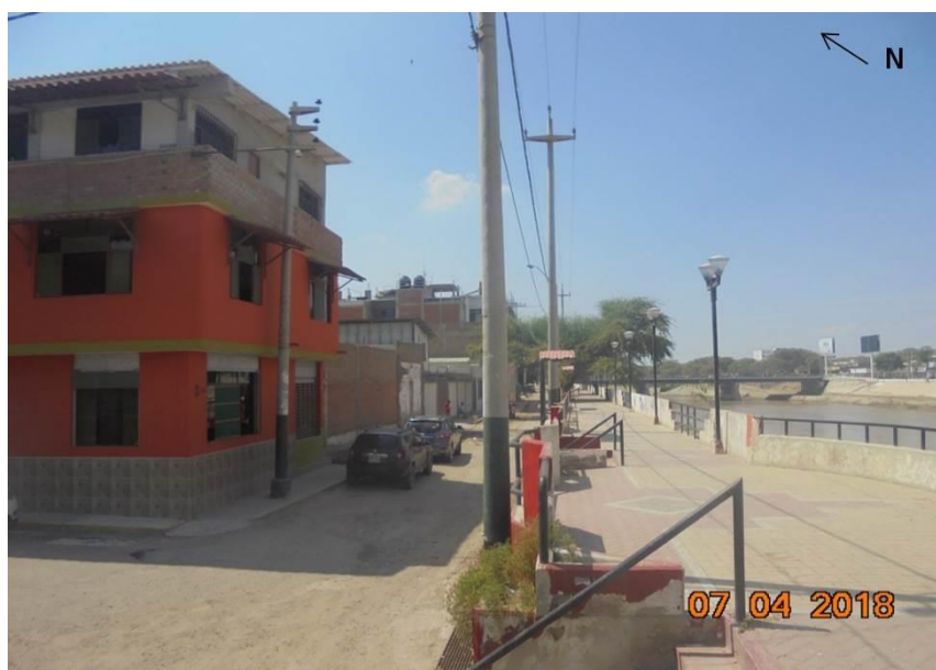
Figura 21: Zona de inundación fluvial, malecón Francisco Eguiguren, Piura cercado.
