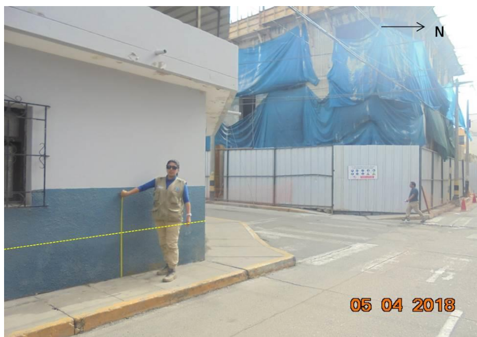
Figura 23: El nivel de inundación alcanzó 0,35 m. en la calle Moquegua cruce con Arequipa con respecto a la acera.
