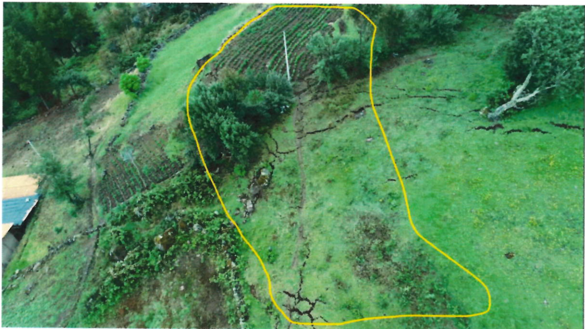
Fotografía 9. Zona inferior del deslizamiento, donde se está acumulando material y necesita ser removida.
