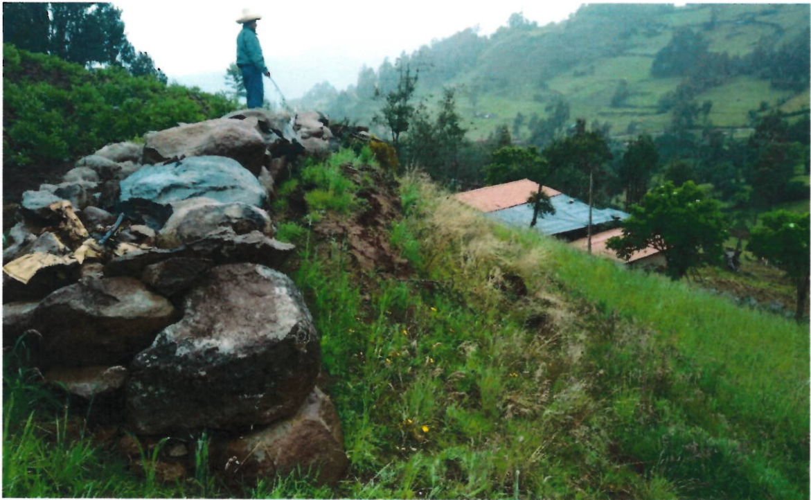
Fotografía 8. Grupo de rocas acumuladas dentro del cuerpo del deslizamiento, que necesitan ser removidas.
