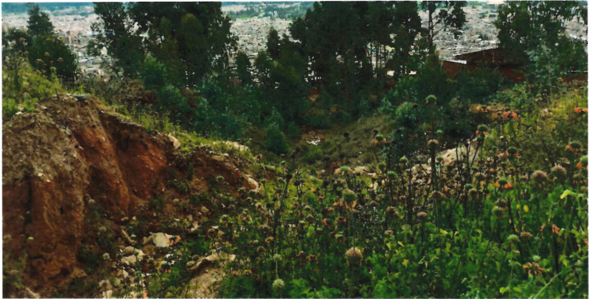
Fotografía 7. Punto de inspección N° 2, zona de quebradas sin encausamiento y con rellenos sólidos.
