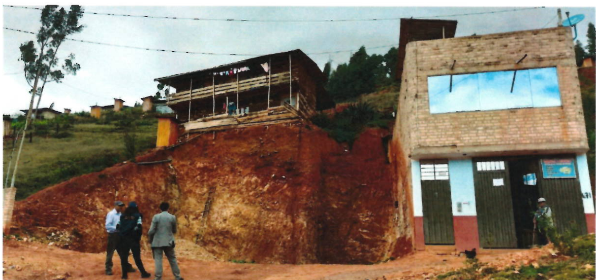
Fotografía 8. Punto de inspección N° 3, cruce con la vía 3N.
