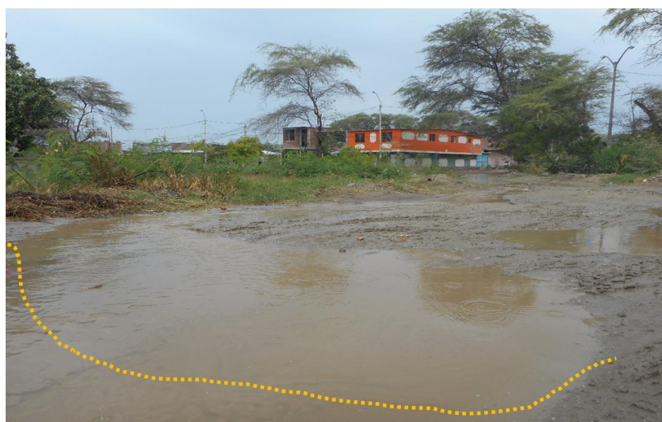
Figura 22: Zona de inundación pluvial, Parque de TÁCALA, se observa una depresión o Cuenca ciega (líneas punteadas).
