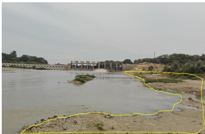
Figura 15: Depósitos fluviales de arena, grava y arcilla (Polígono, amarillo) en ambas márgenes del río Piura, ubicadas a 150 m al sur-oeste de la Presa los ejidos, distrito de Castilla.
