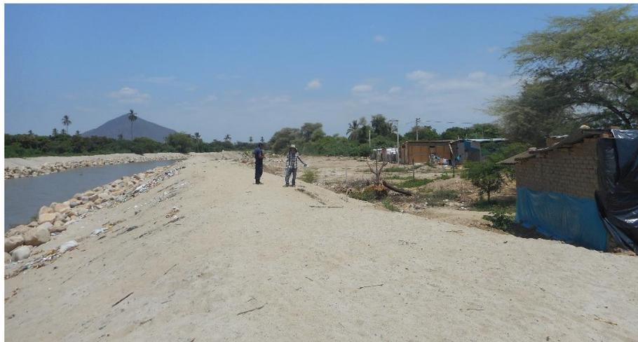
Foto 29: Luego de la inundación del mes de febrero del 2017 se construyeron muros de roca y tierra de hasta 1.5 m de alto.
