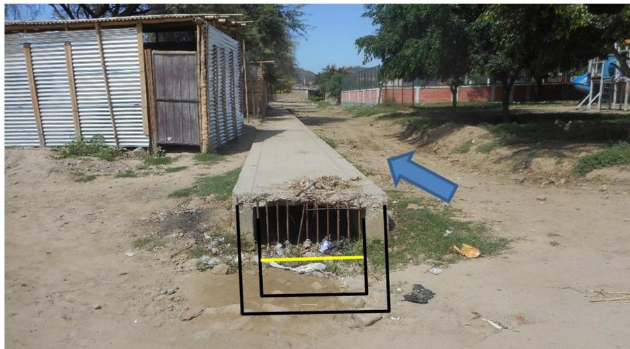
Figura 32: Drenaje colmatado que reduce la capacidad en desborde por lluvias intensas.
