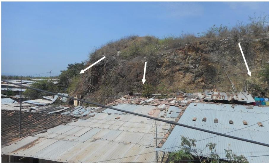
*Figura 37: Las viviendas se ubican muy cerca al talud de los cerros lo que ocasiona que sean afectadas por las caídas de clastos y bloques de rocas.*
