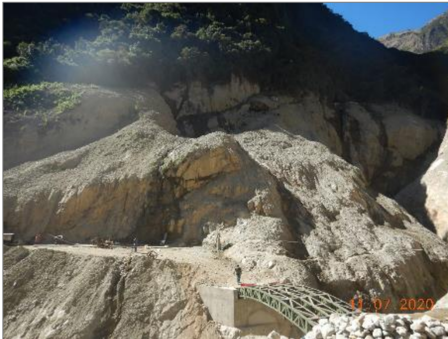
Fotografía 1. Vista del sustrato rocoso fracturado y con intensa meteorización, al NE del sector Collpapampa.
