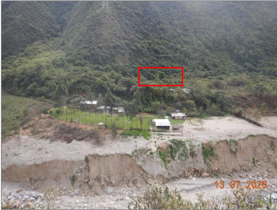
Figura 8. Zona de reubicación propuesta para el sector Wiñaypocco, se ubica a 70 m del cauce del río Salkantay.
