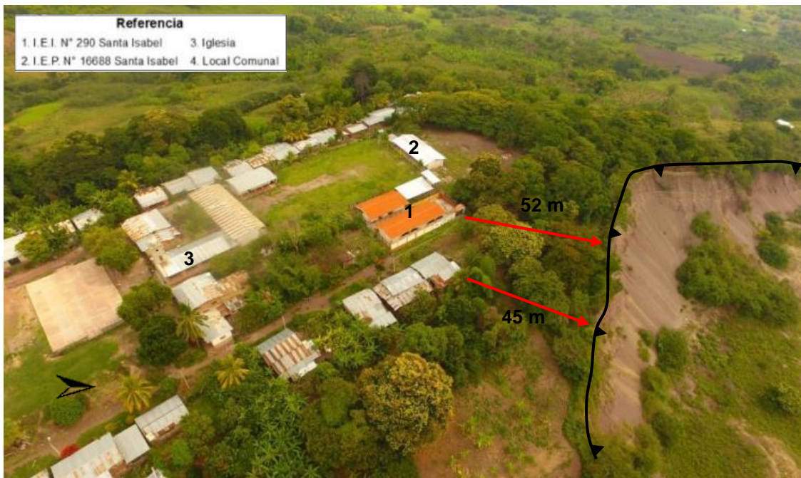
Figura 18. Principales infraestructuras del centro poblado afectada por deslizamientos.
