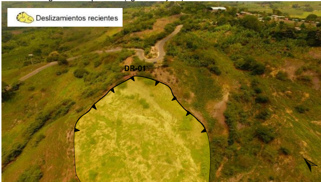
Figura 15. Deslizamiento activo al borde de la vía de acceso asfaltada.
