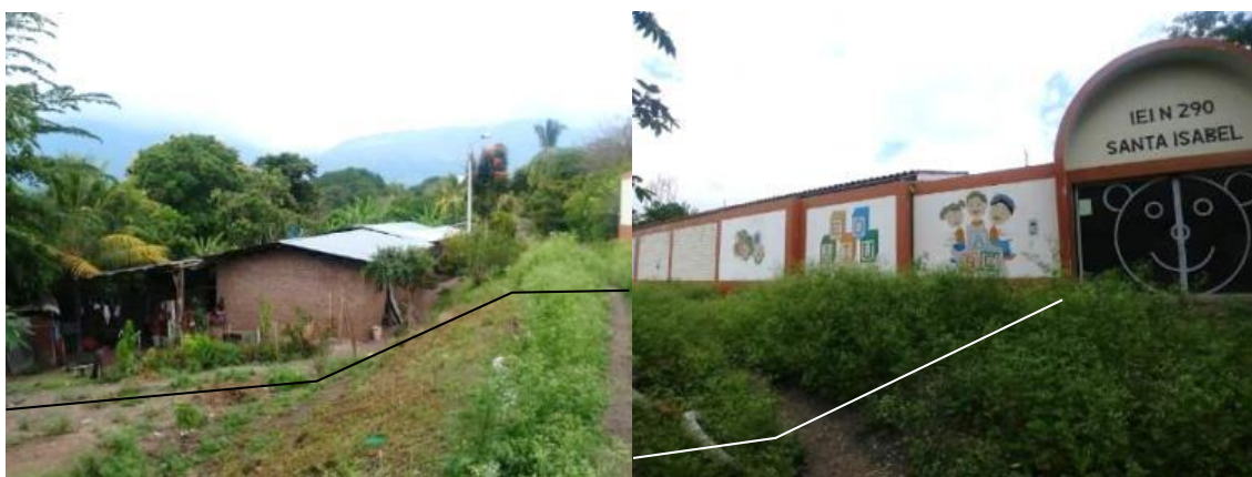
Figura 21. Viviendas y Colegio Inicial próximos al escarpe del deslizamiento.
