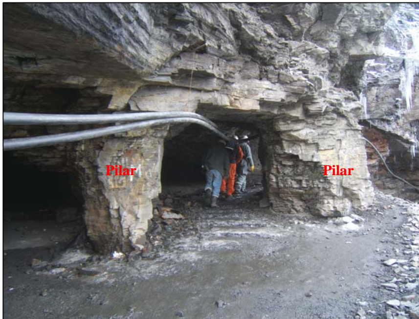
Foto 13.- Pilares que sirven para el sostenimiento de la labor subterránea.
