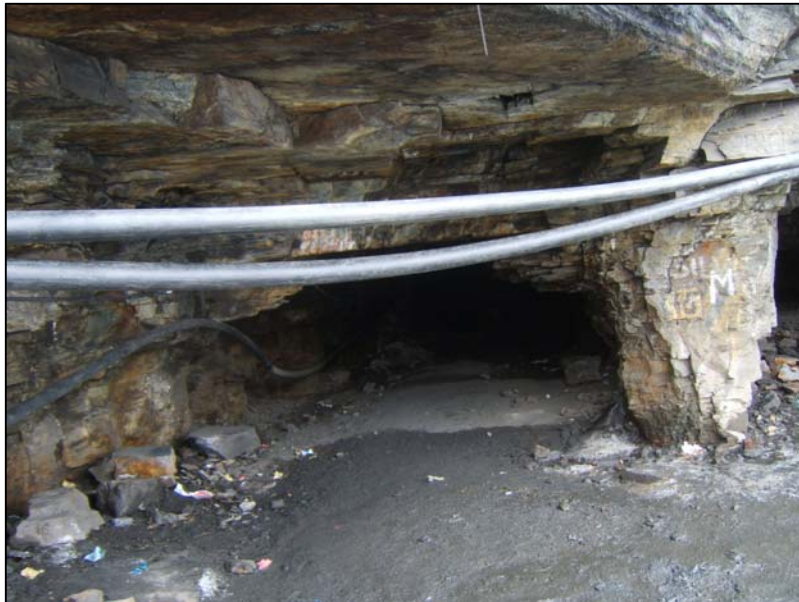
Foto 03.- Afloramiento de cuarcitas y pizarras, la vista superior la roca muy fracturada, y la vista inferior se observa el buzamiento casi horizontal.
