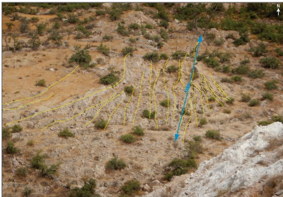
Figura 15. Vista donde se observa grietas continuas con aberturas entre 2cm a 40cm; de hasta 148m de longitud, ubicadas en las coordenadas UTM 8362410 N, 538149 E, con altitud 2574 m s.n.m
