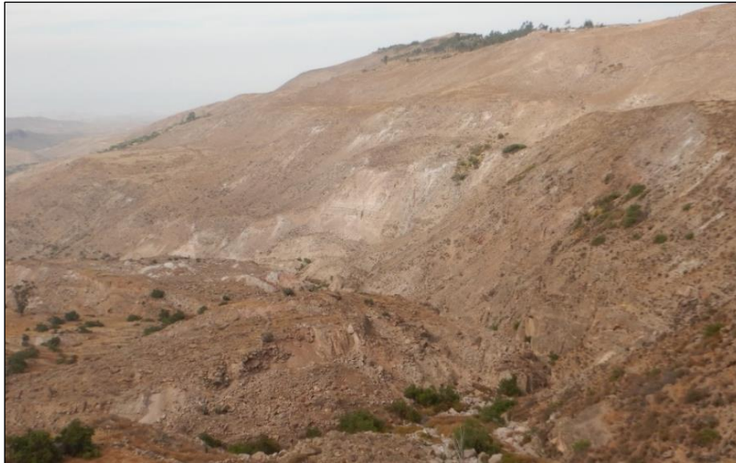
Fotografía 5. Vista con dirección al noroeste donde se observa derrumbes, próximo al poblado Santiago Nuevo.
