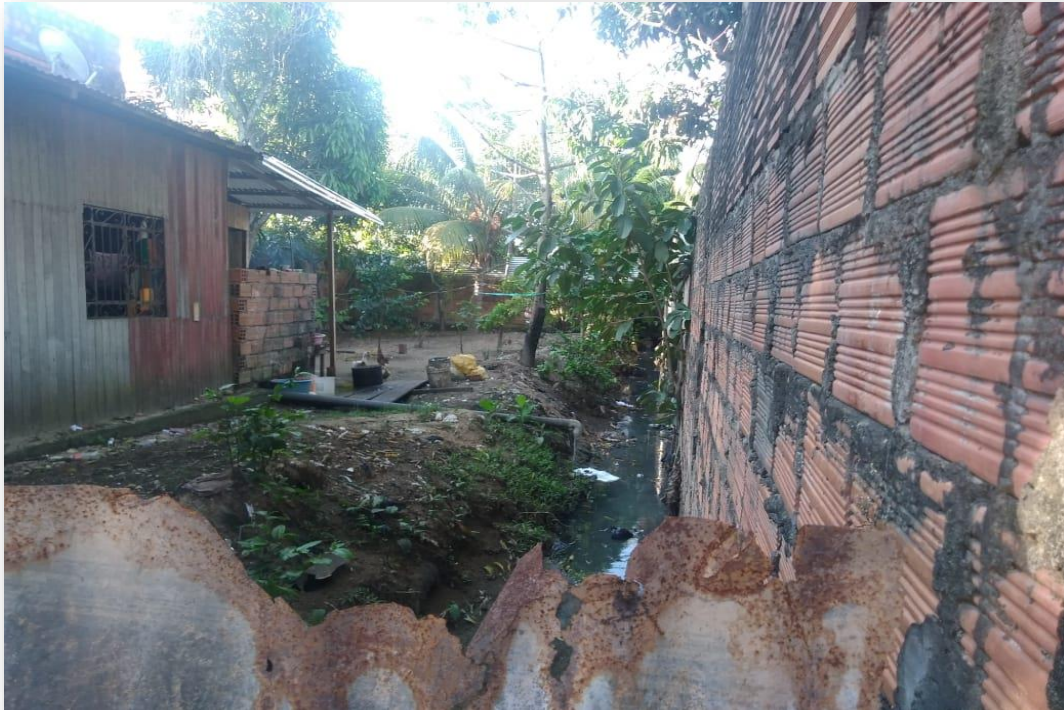
Fotografía N° 11. Cauce de la quebrada natural reducido por construcciones.
