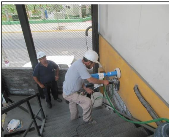
Foto AI-1 Extracción de núcleos de concreto
