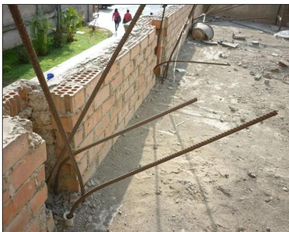
Foto AI-3 Puntos de extracción de muestras de acero
