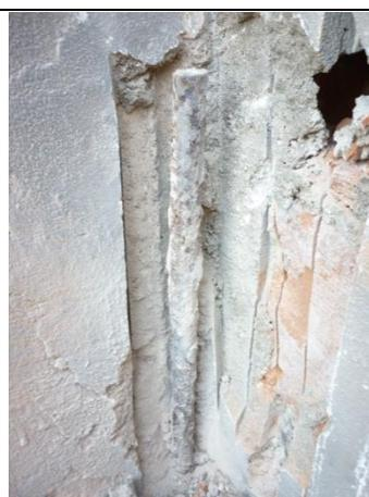
Foto AI-4 Puntos de extracción de muestras de acero
