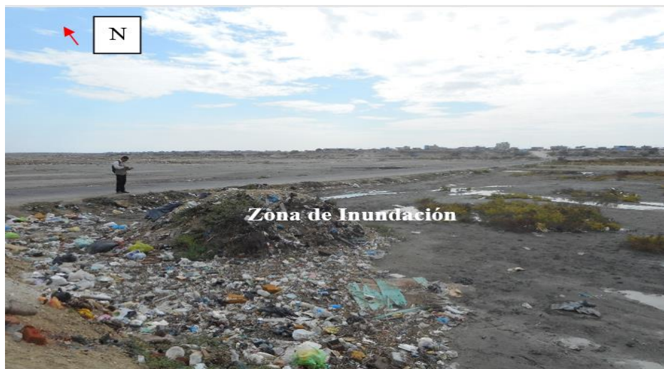
Figura 55: Zonas de inundación por formación de lagunas e inundación fluvial (A.H. La Bocana).
