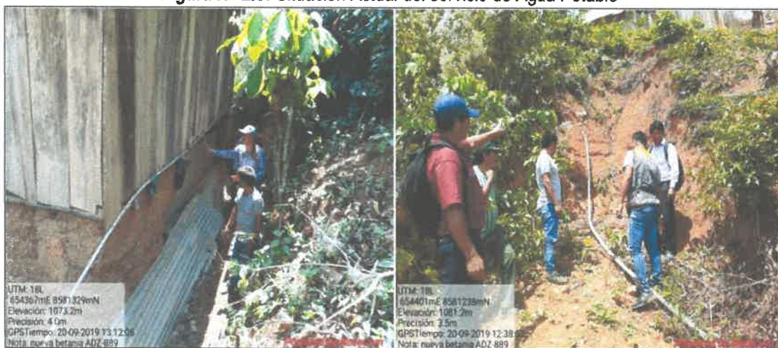
Figura N° 2.8: Situación Actual del servicio de Agua Potable
