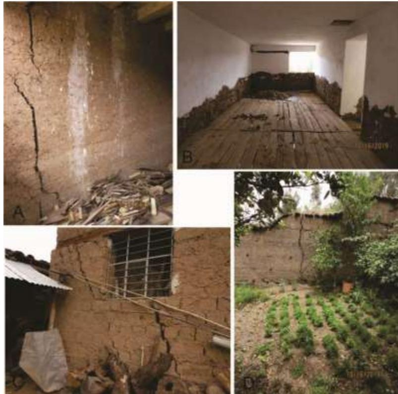
**Figura 9.** En las imágenes (A, B, C y D) se observa grietas en las paredes, cerco y piso en la vivienda ubicada en la corona del deslizamiento
