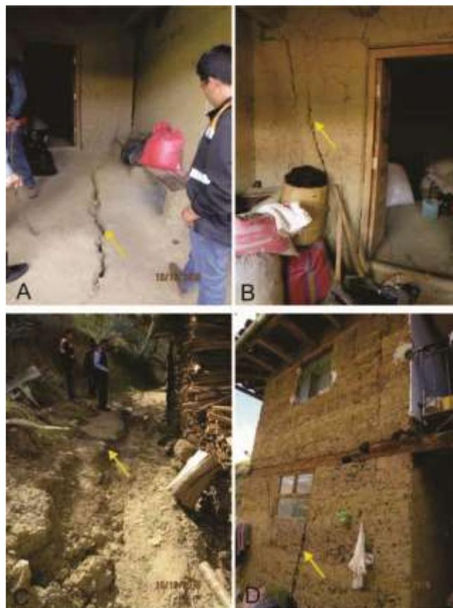
**Figura 10.** Vivienda ubicada en la coordenada UTM: 232606 E - 9020296 N presenta grietas en las paredes y piso (A, B y D), también se observa grieta en el talud superior donde se ubica la vivienda (C).
