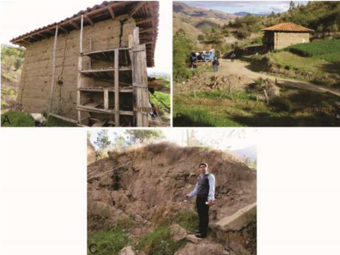
**Figura 11.** La vivienda ubicada en la parte inferior del deslizamiento del sector Dos de Mayo, presenta grietas en las pared (A y B), también se observar grietas con salto vertical de 2m aproximadamente (C)
