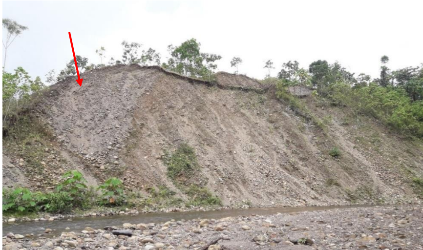
Figura 30. Material (gravas, arenas) trabajado y arrumado por los mineros informales en la margen derecha de la quebrada Machiche.
