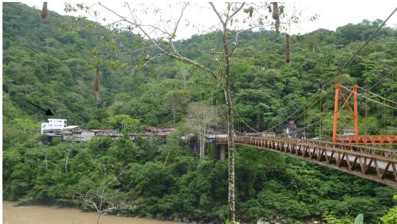
Fotografía 2. Se observa las viviendas del poblado Inambari, ubicados a los costados de la vía Interoceánica.
