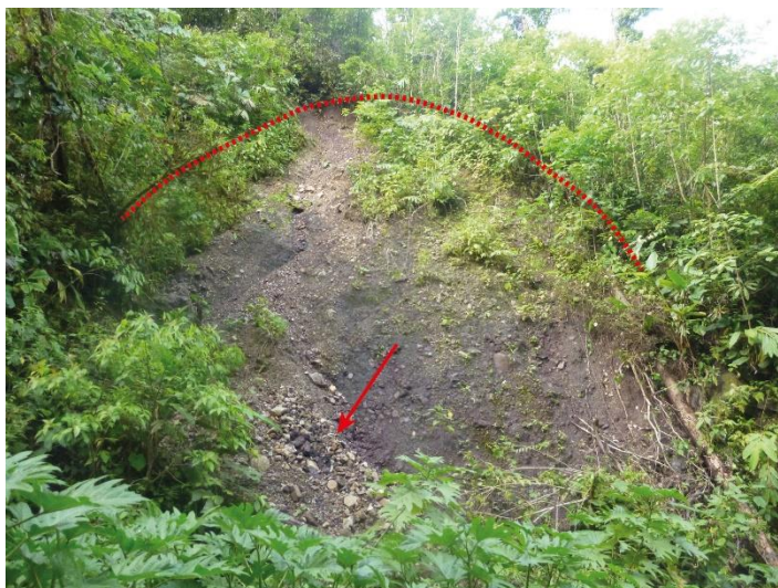
Figura 17 En la quebrada Remal a la margen derecha aguas arriba se identificó derrumbe reciente, donde el substrato rocoso es de mala calidad.
