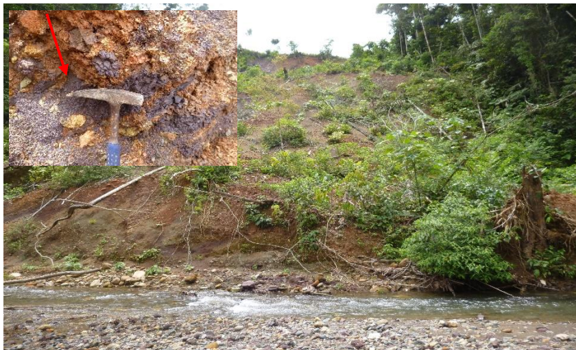
Figura 29. Vista de deslizamiento antiguo en el trayecto de la quebrada, el substrato rocoso es de mala calidad esta intensamente fracturada y meteorizada, (flecha roja).
