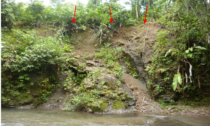
Figura 26. Derrumbes en la margen derecha de la quebrada Machiche.
