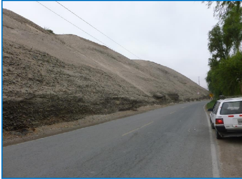
Figura 41: AAHH El Canto y corte de talud en el cual se observa la secuencia estratigráfica de los depósitos aluviales.
