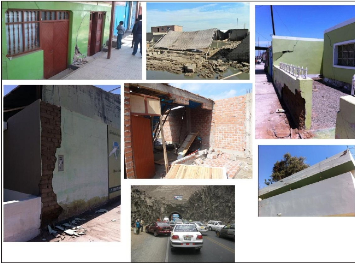
Figura 12: Imágenes de daños observados en las ciudades de Acarí, Bella Unión, Yauca y Chala debidos al sismo del 25 de setiembre de 2013.
