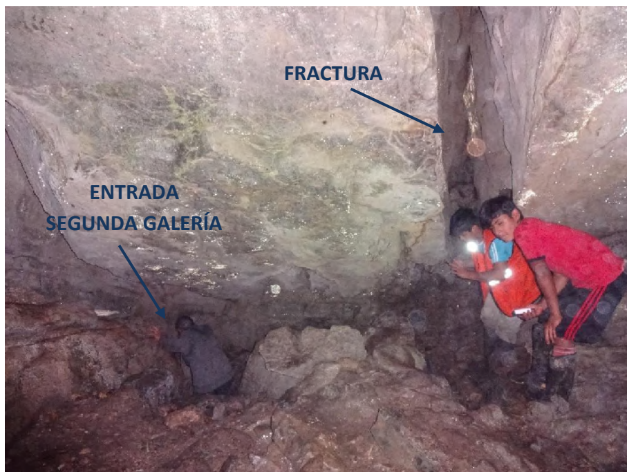
Figura 17: Fracturas en roca, en la primera cámara de la cueva Huacharos, ubicada a 5 m de la entrada en un desnivel de 3 m.
