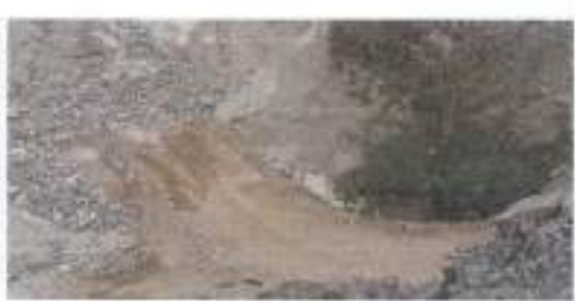
Detalle de Tramo erosionado que ocasiona caídas. Prolado:
