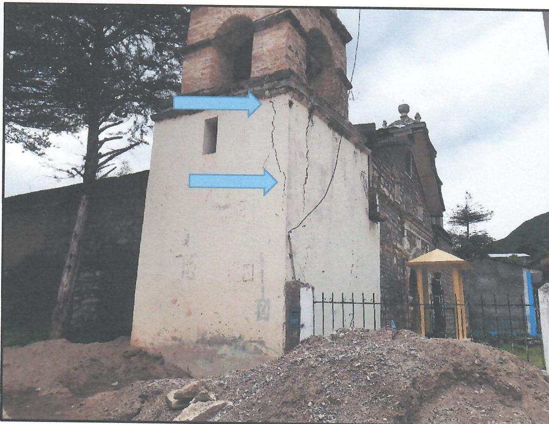
**Imagen 14:** fotografía, fisuras en la iglesia de cuenca producido por el deslizamiento de tierra, ubicado a 80 m.
