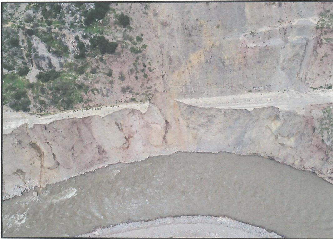
**Imagen 17:** fotografía aérea (Drone), Colapso y pérdida de Plataforma de la vía férrea y socavamiento de Talud por las aguas del Rio Mantaro ya que originaría un posible Deslizamiento.
