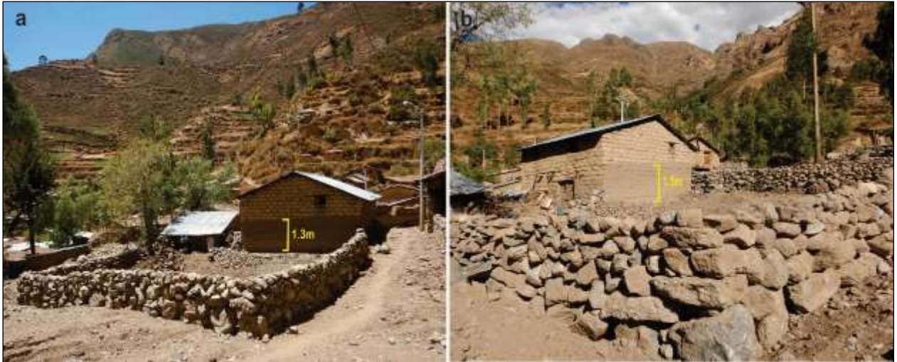
Figura 13. Vista donde se observa rastros del nivel del flujo de detritos (huaico) que varía entre 1 a 1.5 m, ubicado en las coordenadas UTM 8495442 N, 556916 E, con una altitud 3324.
