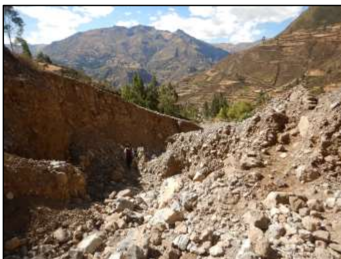
Fotografía 9. Vista al norte del centro poblado de Cocas, donde se puede observar el material transportado por el flujo de detritos (huaico), así como la profundidad que llego a 5 m y un ancho promedio de 4 a 6.
