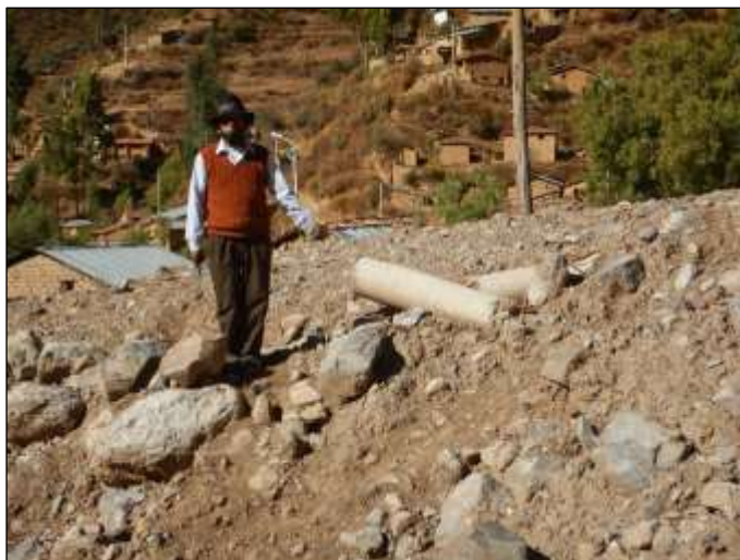
Fotografía 7. Postes de concreto de tendido eléctrico destruidos.
