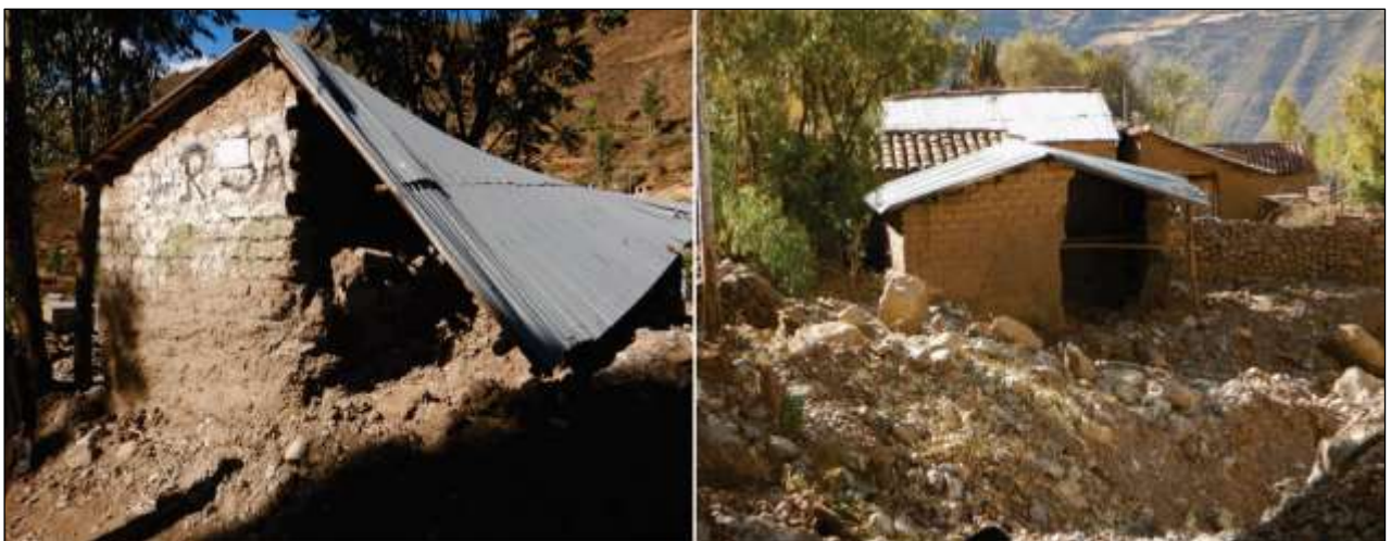
Fotografía 7. Se identificaron los daños ocasionados por el flujo de detritos (viviendas destruidas y deshabitadas).
