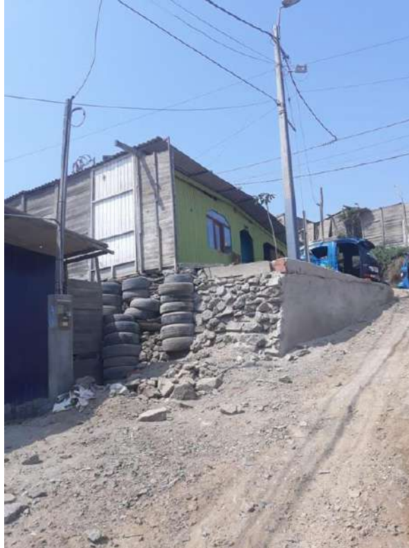
Fotografía N° 3. Viviendas de material precario, no tienen cimentación
