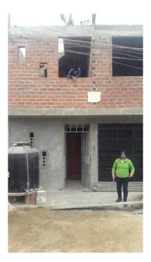
FOTOGRAFÍA N° 5. Mz. N, vivienda en construcción con material de ladrillo, cimiento de concreto y en buen estado.
