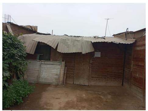
FOTOGRAFÍA N° 8. Mz. T, vivienda de material de madera, no cuenta con cimiento y se encuentra en mal estado.
