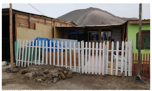
FOTOGRAFÍA N° 12. Mz. U, lote 14 vivienda de material de madera, cimiento de concreto y se encuentra en buen estado.
