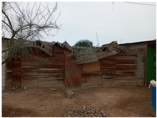
FOTOGRAFÍA N° 9. Mz. T, vivienda de material de madera, no cuenta con cimiento y se encuentra en un mal estado.
