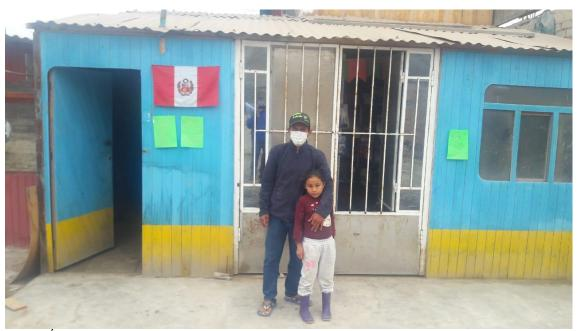
FOTOGRAFÍA N° 3. Mz. N, Lote 28 vivienda con material de madera, cimiento de cemento y estado regular.
