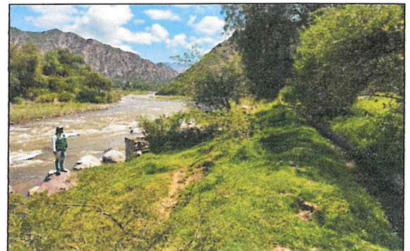
Vista de la bocatoma de Andabamba en riesgo, por erosión del río Cachi
