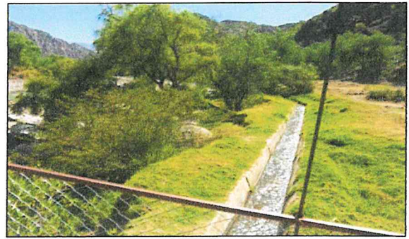
Vista de las infraestructuras viales y de conducción en el sector "Andabamba", consta de Canal de Conducción de material concreto simple.
