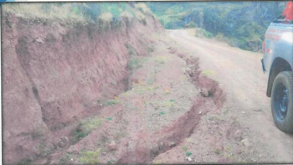
Foto 52. Grietas de tensión en la trocha - vía Culispata.
