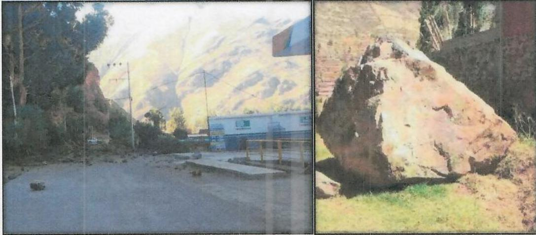
Foto 84 y Foto 85. Derrumbe en el sector de Huanu y macizo rocoso con diámetro mayor a 3 metros.
