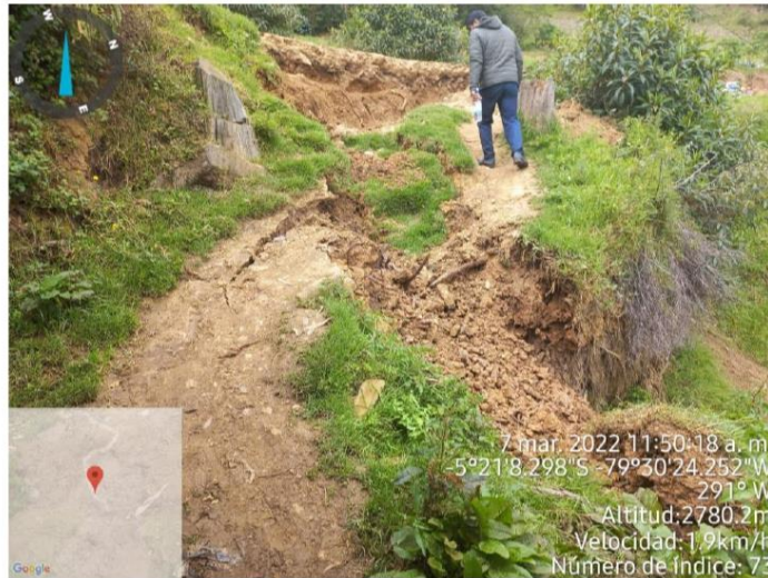
Fotografía 01: Derrumbe debido a las lluvias intensas en el Distrito de Sondorillo
