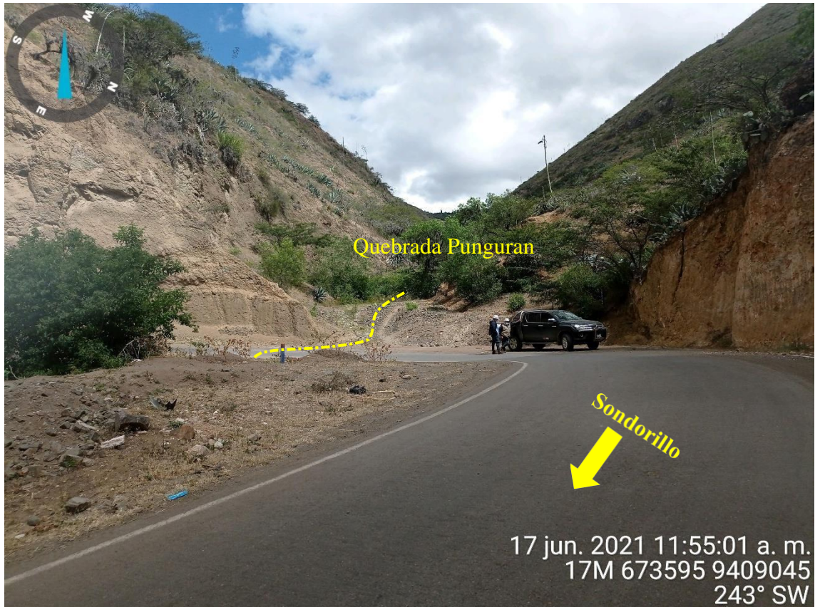
Fotografía 05: Cauce de la quebrada Pungurán. Los flujos de detritos podrían afectar la vía asfaltada Sondorillo – Rumi Corral.
