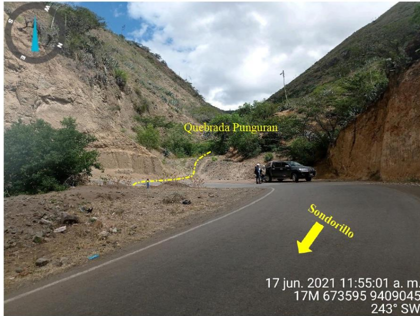
Fotografía 8: Cauce de la quebrada Pungurán. Los flujos de detritos podrían afectar la vía asfaltada Sondorillo - Rumi Corral.
