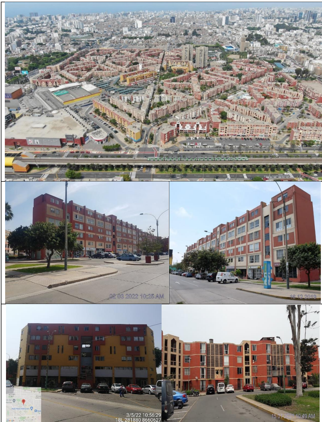
Imagen 6.- Imágenes panorámicas del Subsector 10B y 10C del distrito de San Borja
