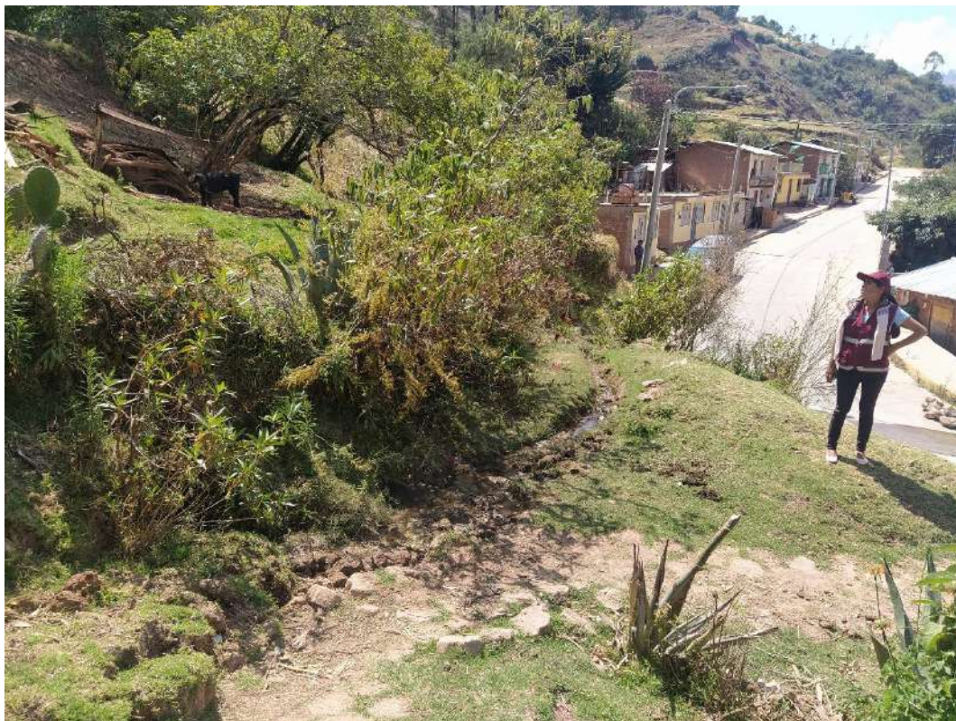
Fotografía 5. Salida de la quebrada Pajchicucho, obsérvese como parte fluye por la canalización pluvial del sector Pajchicucho y centro poblado Ongoy, mientras que parte se infiltra pasando subterráneamente por el poblado.
