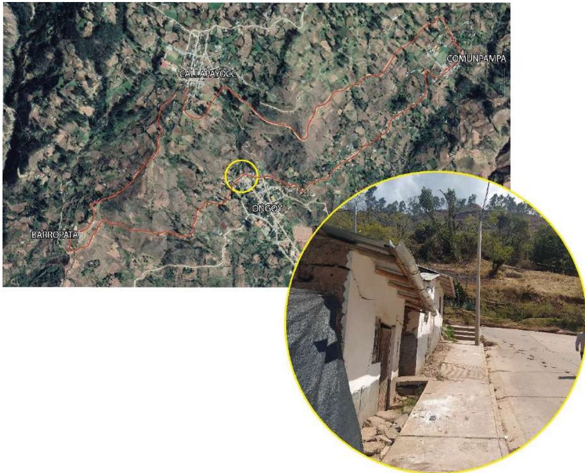
Figura 30. Se observan 48 m de carretera afectada, que conectaba alternativamente a Ongoy con los poblados de Barropata y Comunpampa.
