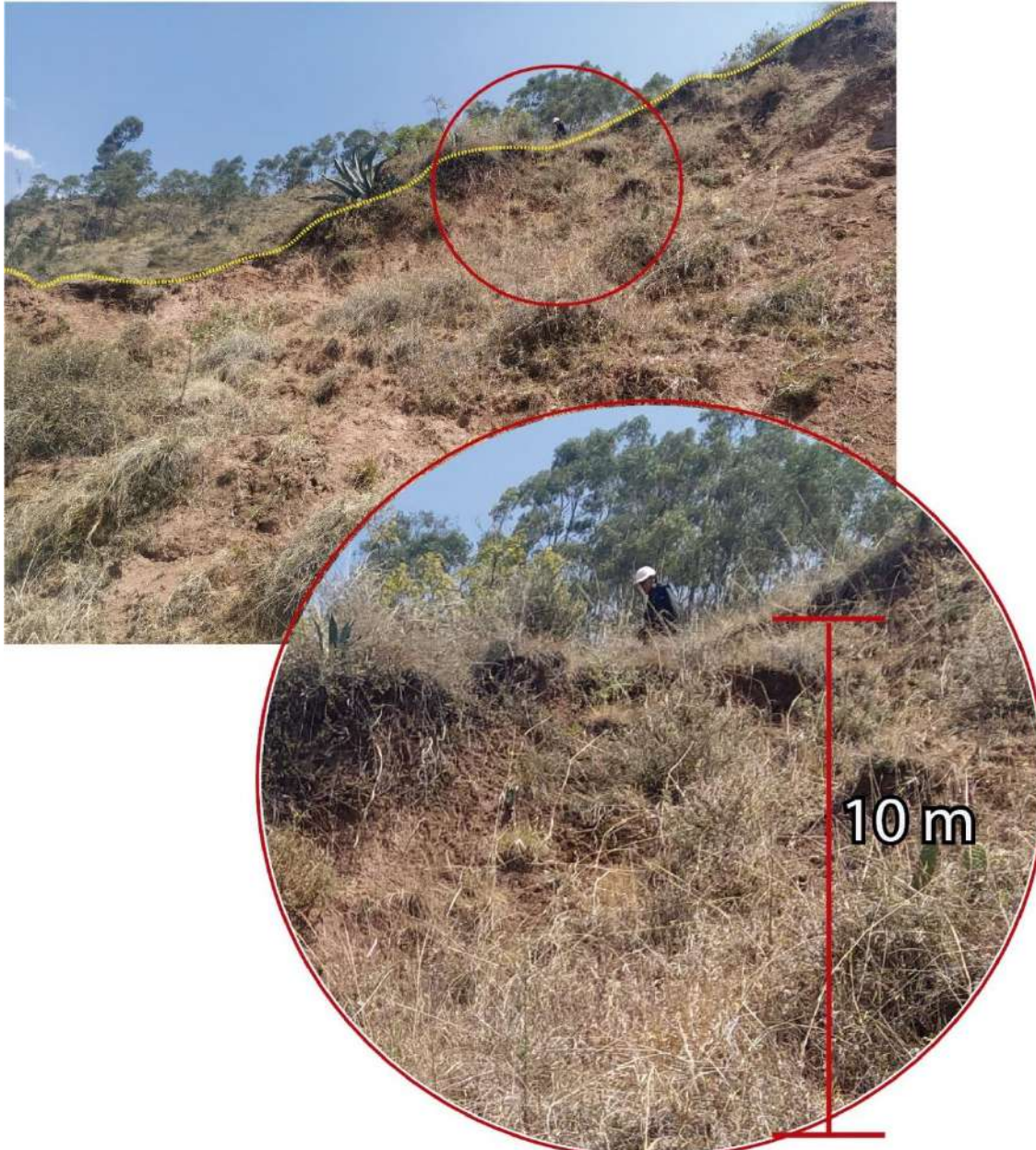
Figura 21. Altura de la escarpa principal del deslizamiento de Pajchicucho DR1.
