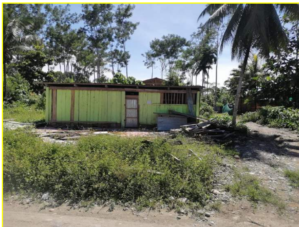
Fotografía N° 12 Vista de viviendas expuestas del sector 01 (Natalio Sánchez), construidas en base a madera y calamina.
