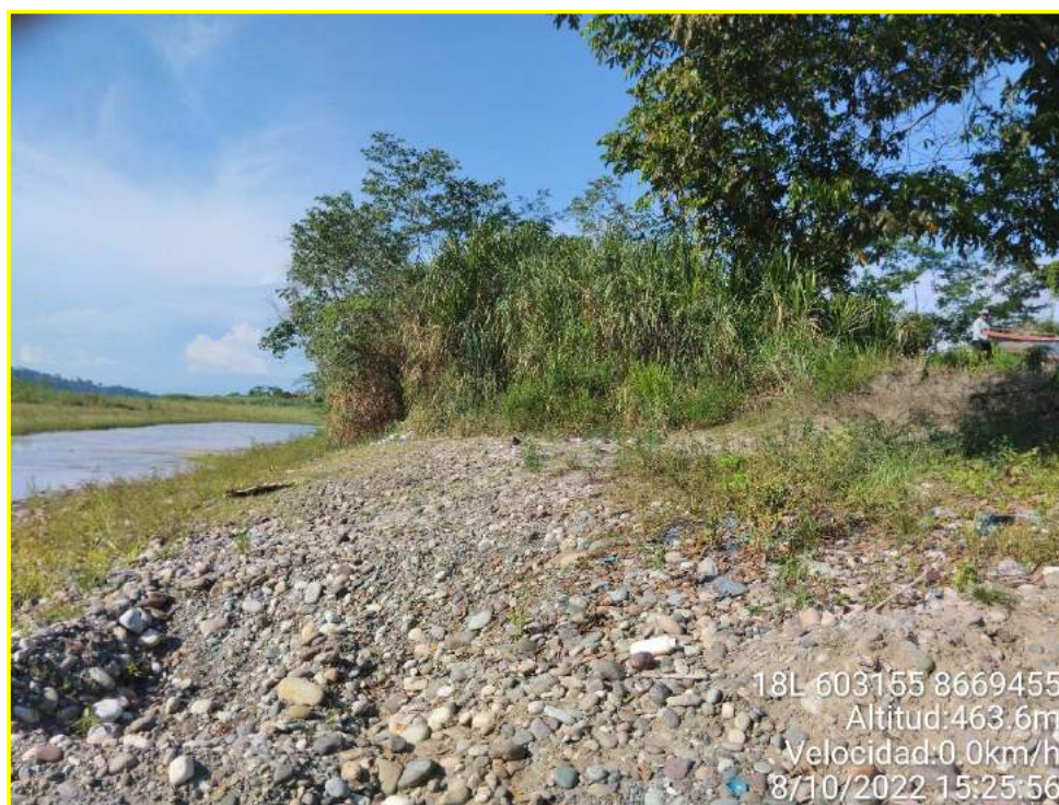
Fotografía N° 05. Vista de áreas susceptibles a la ocurrencia de inundación fluvial del sector 01 (Natalio Sánchez).
