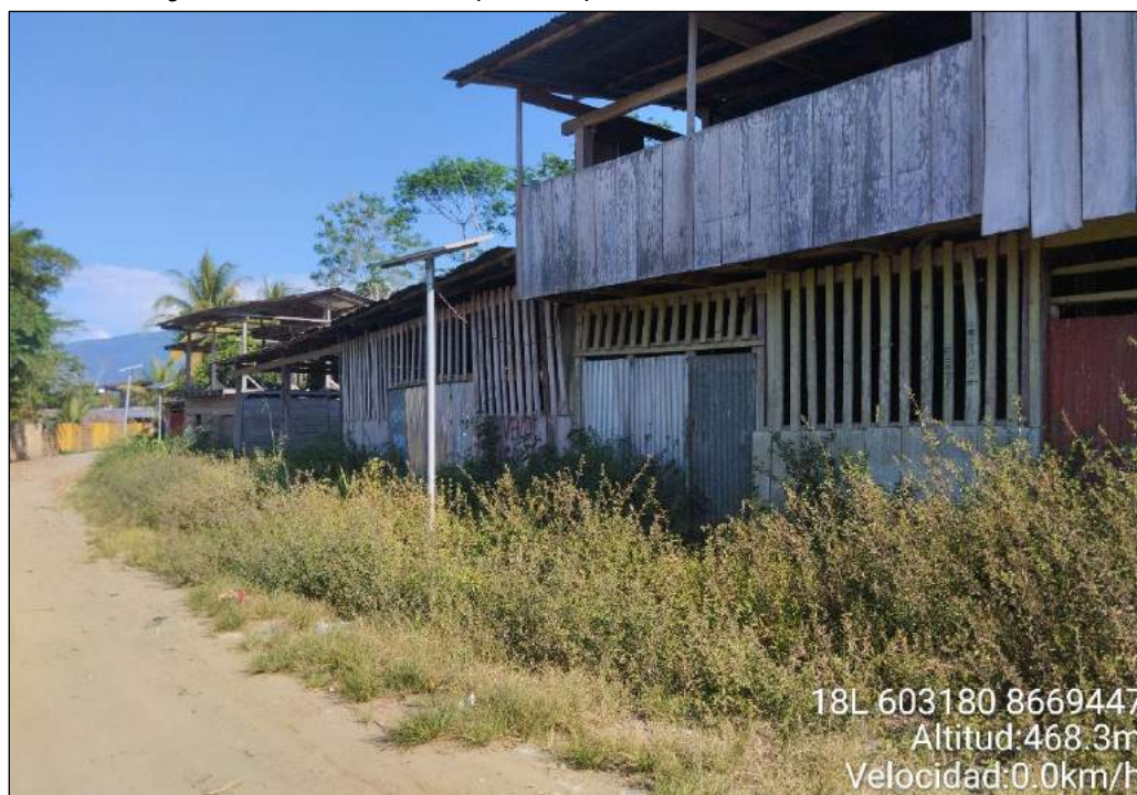
Figura N° 015. Viviendas expuestas, poblado Natalio Sánchez
