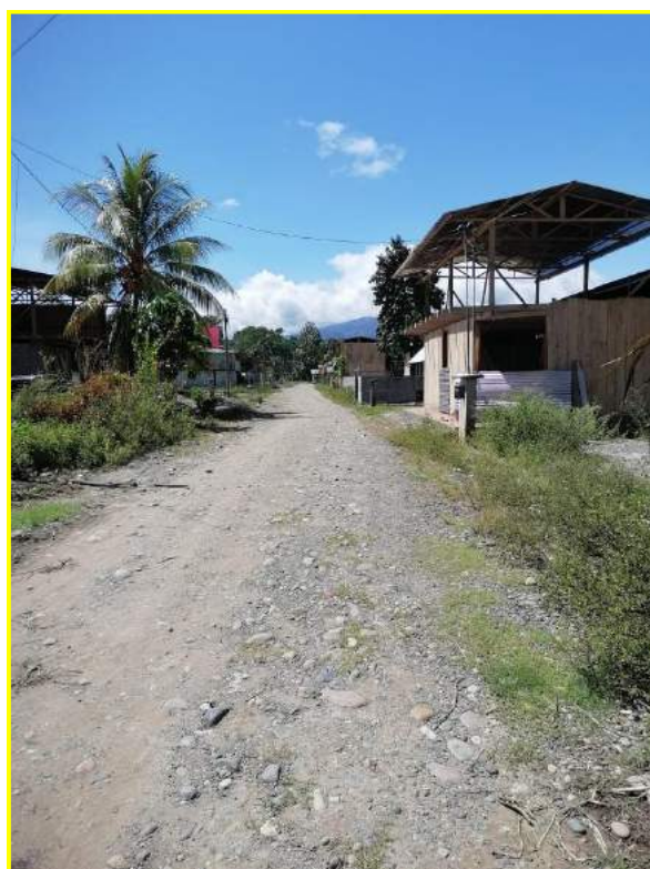
Fotografía N° 11 Vista de viviendas expuestas del sector 01 (Natalio Sánchez), construidas en base a madera y calamina.
