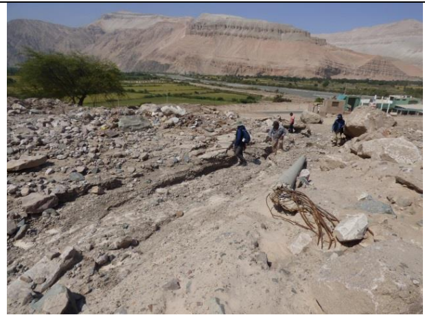
Imagen 74: Izquierda se aprecia una vivienda afectada y parcialmente enterrada por el flujo. Derecha, sector que destruyó viviendas, se aprecian los vestigios de postes de tendido eléctrico y lozas de viviendas.
