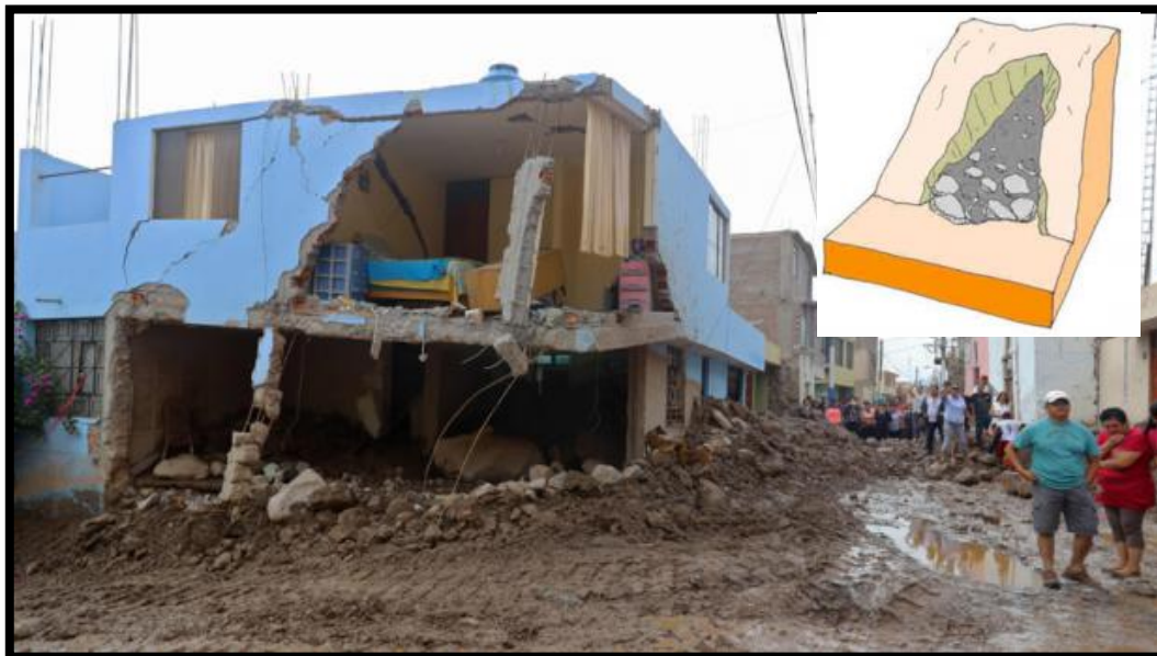
Imagen N° 14: Avalanchas de lodo en el Distrito de Aplao
