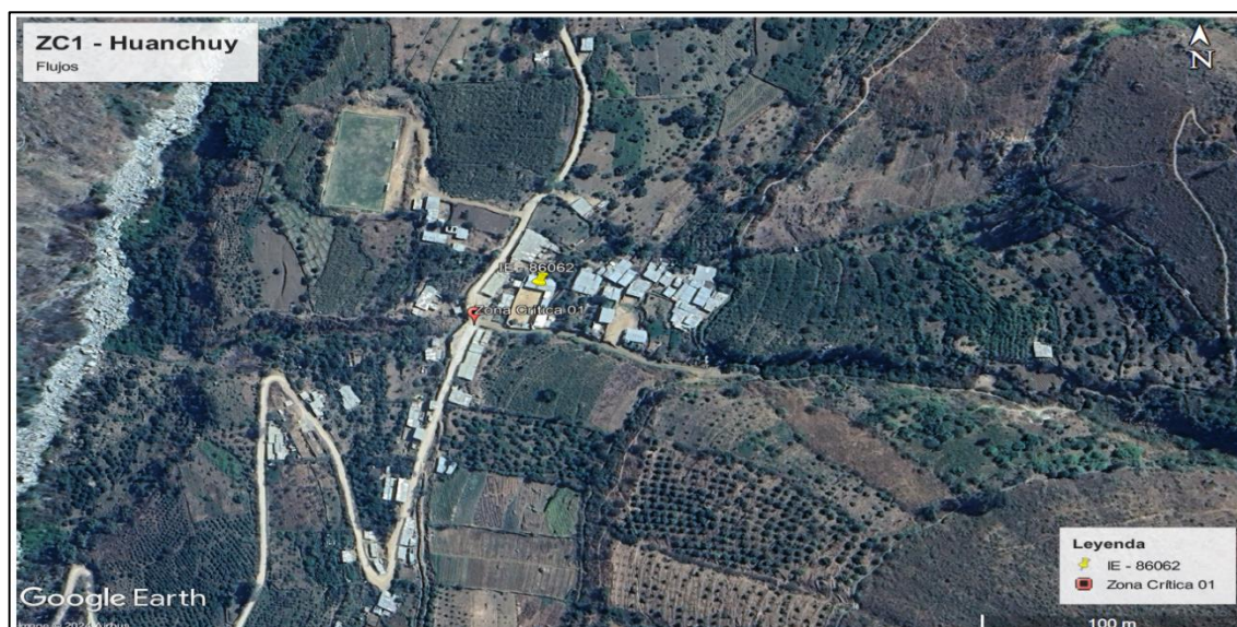
Figura 32. Ubicación de la zona crítica – Huanchuy
