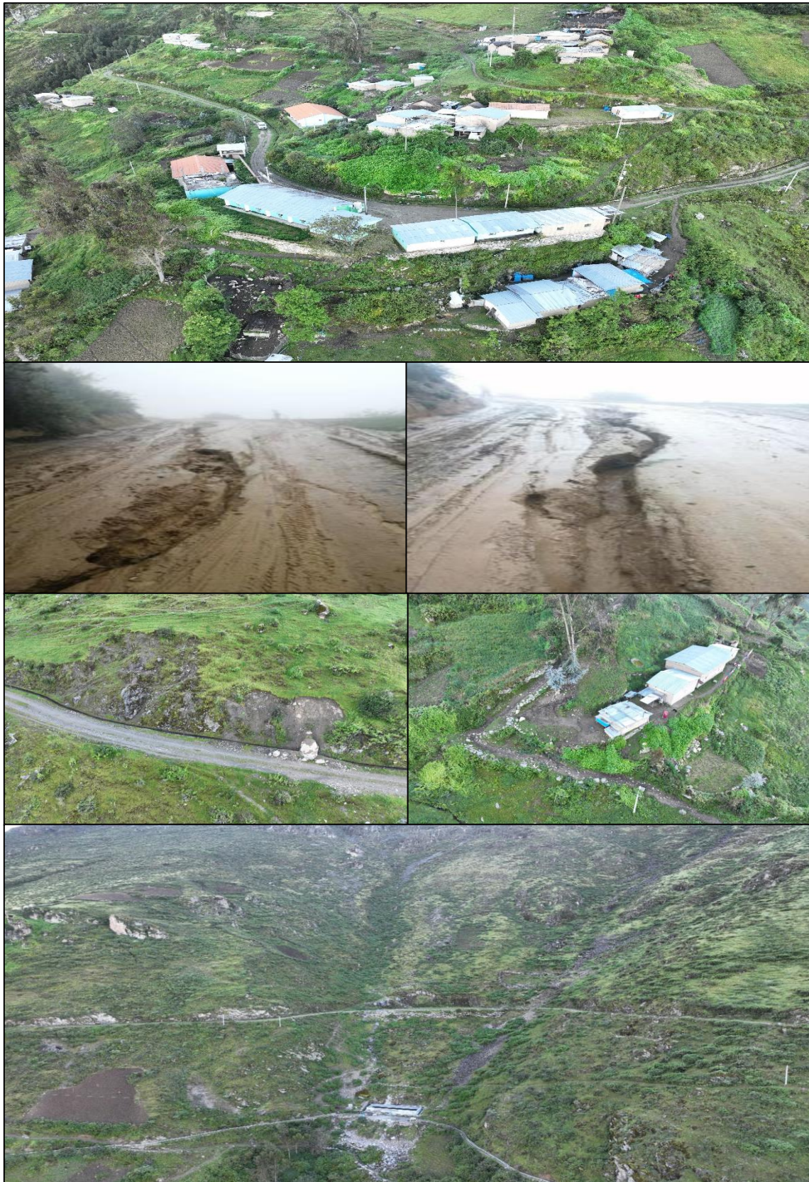
Figura 46. Afectaciones de lluvias intensas y flujos – deslizamiento – Elementos expuestos
