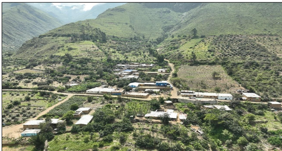
Figura 33. Vista panorámica de la zona crítica – Huanchuy
