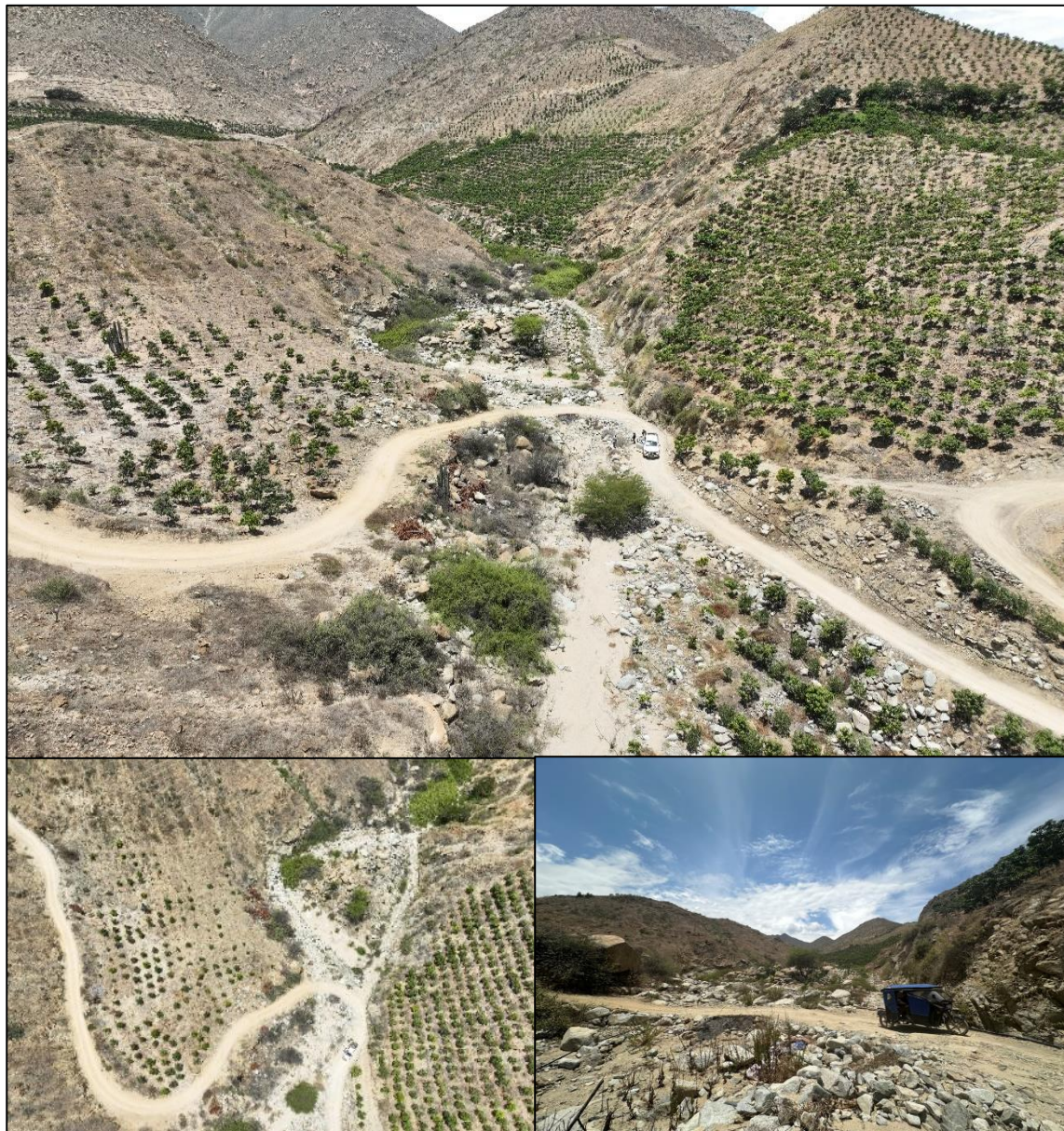
Figura 39. Vista panorámica de la zona crítica y principales afectaciones
