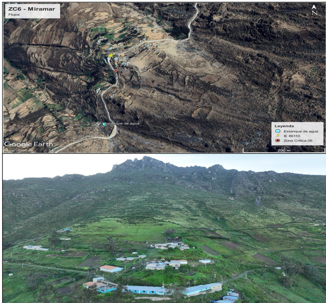
Figura 45. Ubicación de la zona crítica - Miramar
