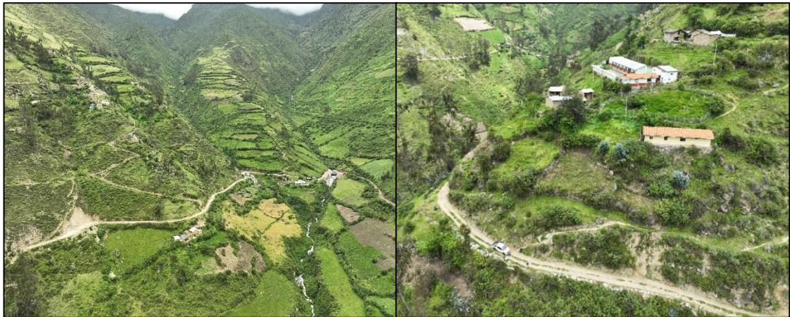
Figura 62. Vista panorámica de la zona crítica – vías afectadas
