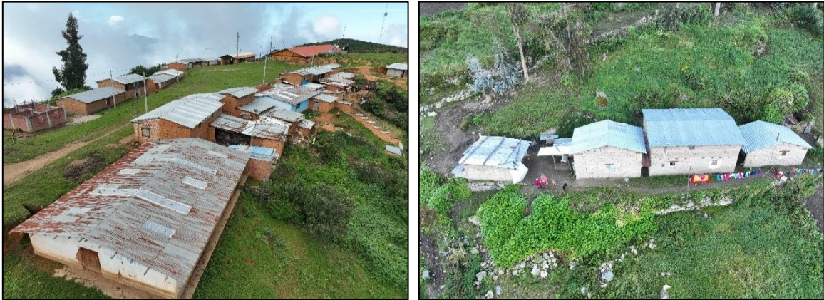
Figura 80. Viviendas expuestas a movimientos en masa
