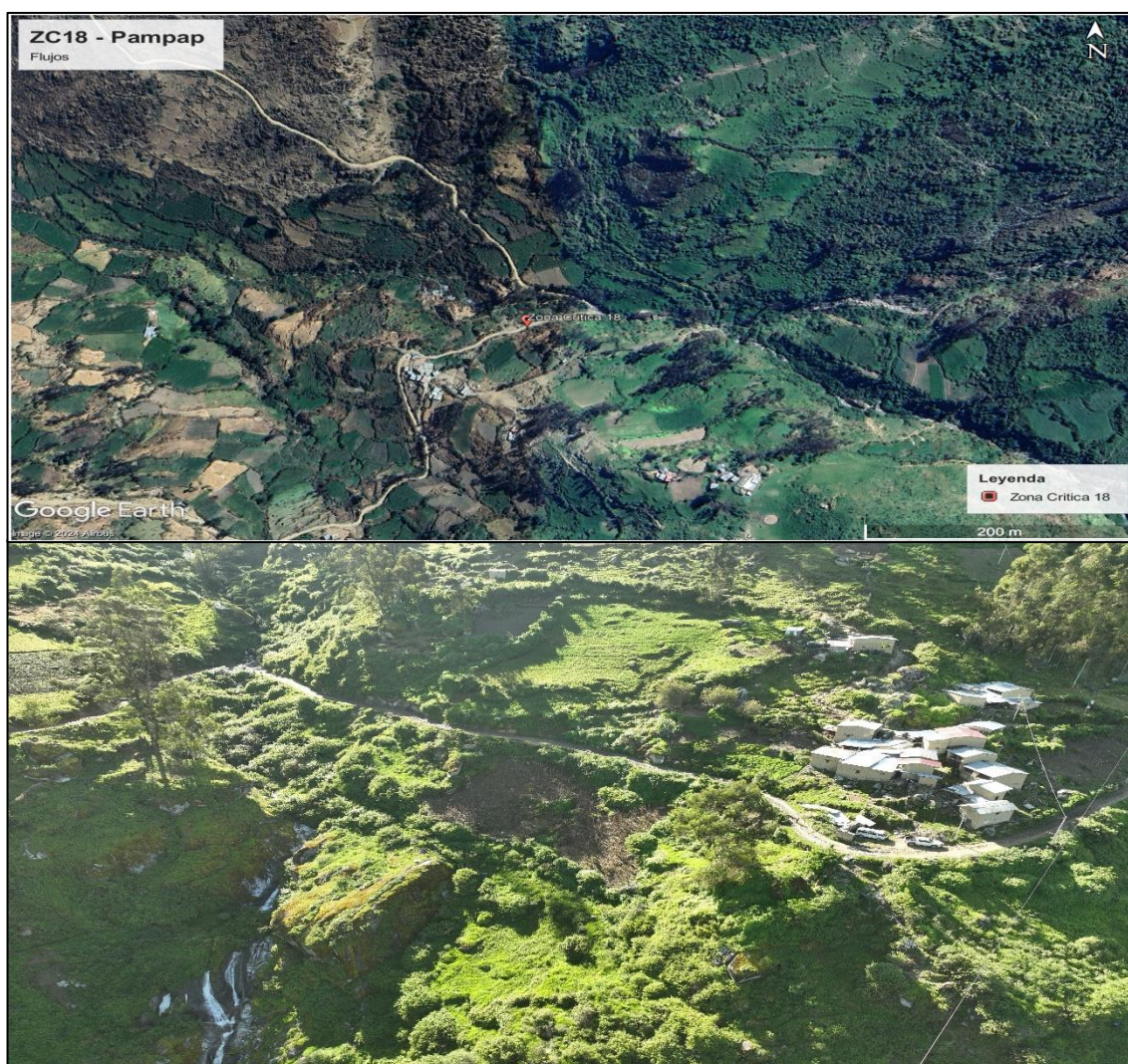
Figura 69. Ubicación de la zona crítica – Pampapu
