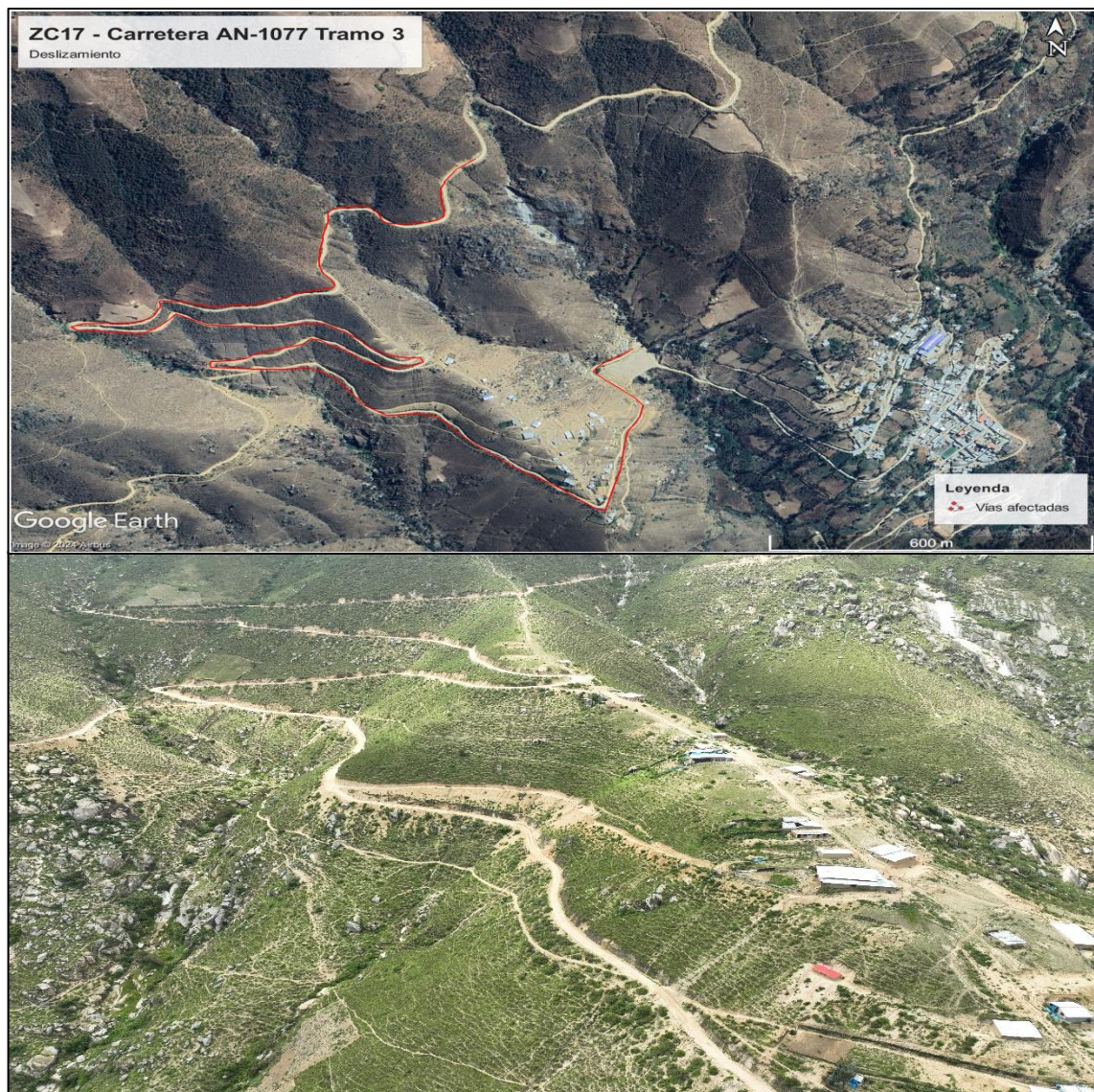
Figura 67. Ubicación de la zona crítica – Carretera AN-1077 Tramo 3 – Urb. Santa Ana
