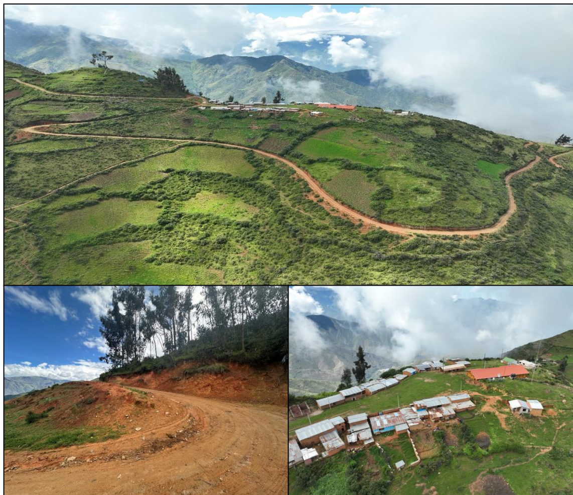
Figura 54. Vista panorámica de la zona crítica – sueño arcilloso – elementos expuestos
