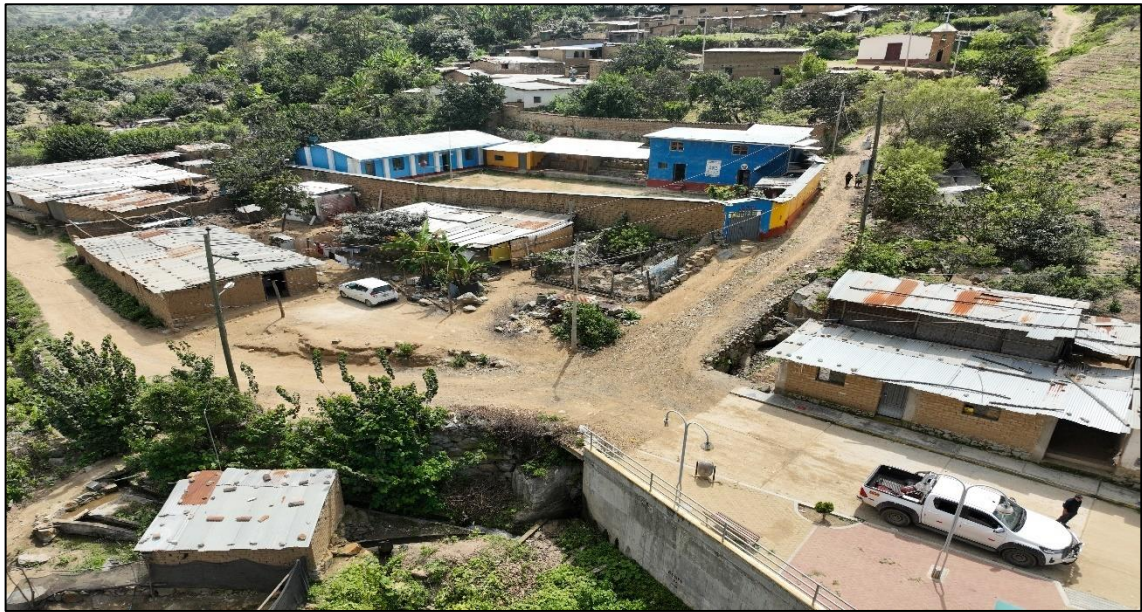
Figura 34. Vista panorámica de elementos expuestos y viviendas afectadas
