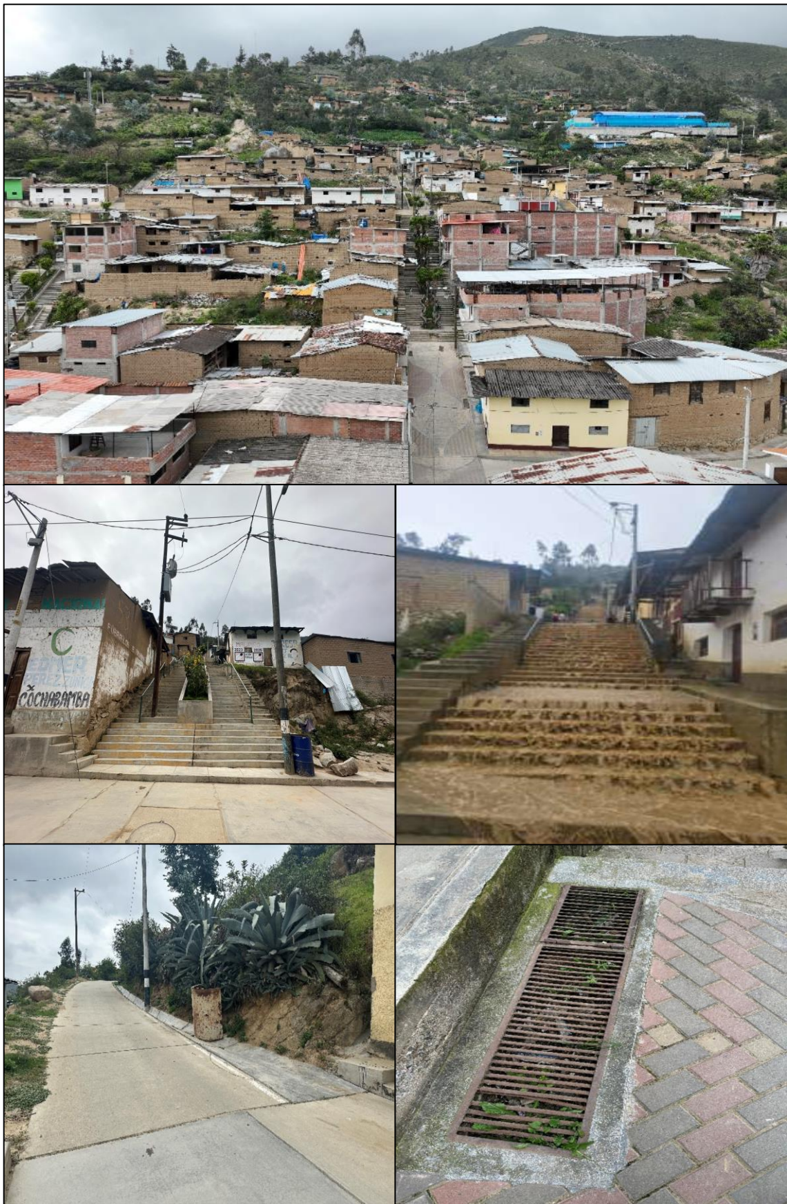
Figura 41. Vista panorámica de la zona de crítica - sistema de drenajes colapsado y falta de mantenimiento
