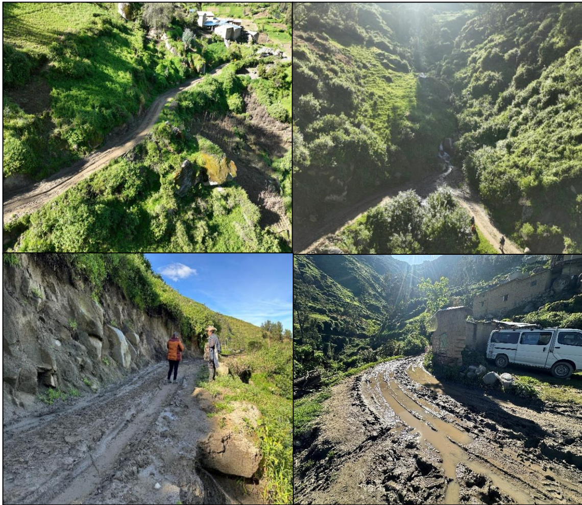
Figura 70. Afectaciones en la vía AN-1135
