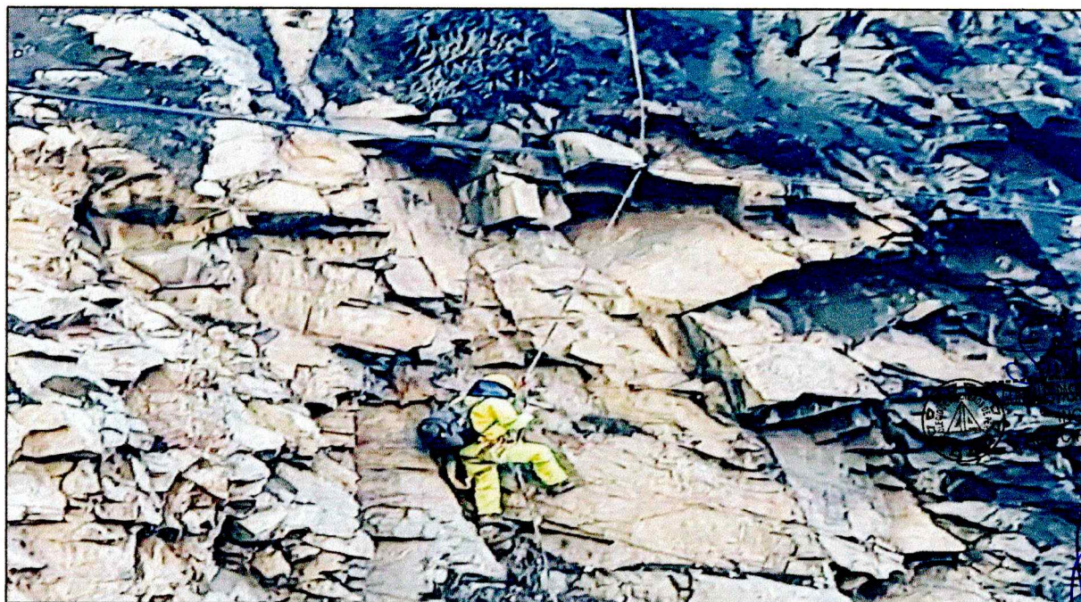
EJEMPLO DE DESQUINCHE DE ROCAS SUELTAS, EN EL QUE SE OBSERVA EL EXTREMOS SISTEMA DE SEGURIDAD DEL PERSONAL
