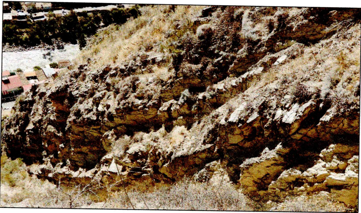
FOTOGRAFIA 1: VISTA DEL SUBSTRATO ROCOSO CONSTITUIDO POR CALIZA MUDSTONE DE COLORACIÓN BEIGE, DE LA FORMACIÓN CHÚLEC. SUPERFICIALMENTE EL MACIZO ROCOSO SE ENCUENTRA FUERTEMENTE FRACTURADO, CON ESPACIAMIENTOS PRÓXIMOS ENTRE SÍ, ABERTURAS ABIERTAS A MUY ABIERTAS Y SIN RELLENO VISIBLE. COORDENADAS REFERENCIALES UTM WGS-84, 18S: E: 500354; N: 8617831
