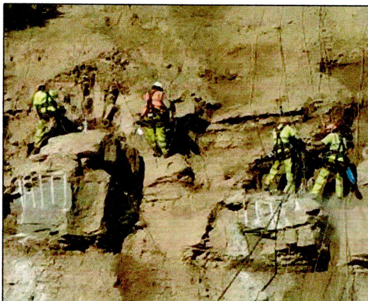
EJEMPLO DE DESQUINCHE DE ROCAS SUELTAS, EN EL QUE SE OBSERVA EL EXTREMOS SISTEMA DE SEGURIDAD DEL PERSONAL
