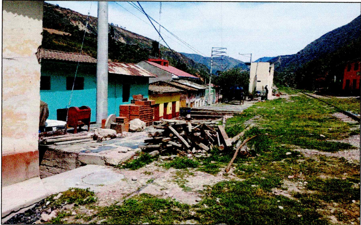
EN ESTA VISTA SE OBSERVA LOS ELEMENTOS EXPUESTOS, QUE SE ENCUENTRAN EN ZONA DE RIESGO ALTO Y MEDIO (VISTA DE ESTE A OESTE)
