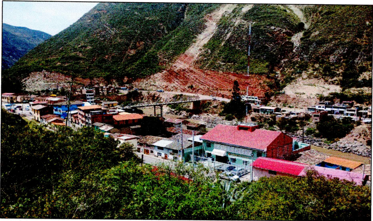
EN ESTA VISTA SE OBSERVA LOS ELEMENTOS EXPUESTOS (COMISARIA PNP), MUY CERCANOS A LA ZONA DE CAIDA DE ROCAS PROVENIENTES DEL CERRO CCECHCCAMARCA (VISTA DE SUR A NORTE)
