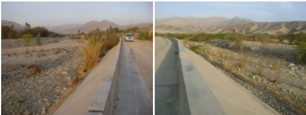
Izquierda, se observa el río Palpa aguas arriba de la Panamericana. Derecha, se observa el río Viscas aguas arriba de la carretera Panamericana. Como se puede apreciar el flujo es cero, incluso la vegetación sobre el cauce se muestra marchitada (foto tomada en Noviembre de 2010).
