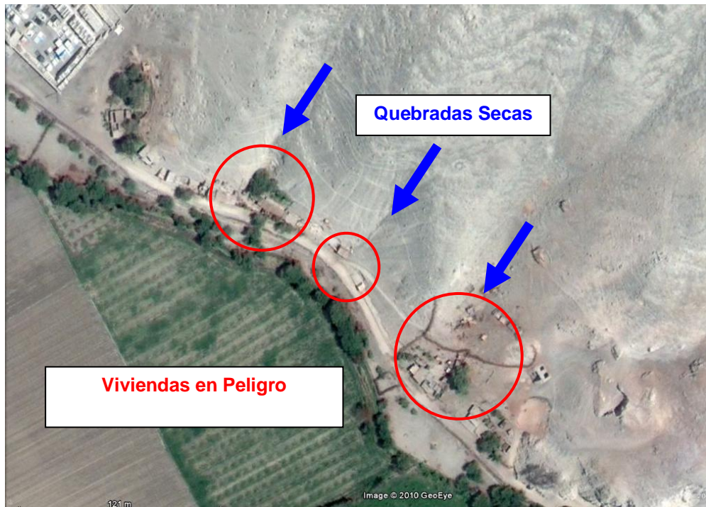
Se muestra las quebradas secas de la zona de San Pedro de Carapo, y viviendas en peligro.
