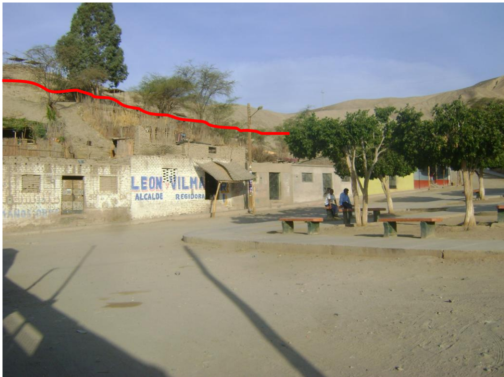
En la foto se observa el AA. HH. San Ignacio y por encima se tiene el canal de riego María Yolanda.
