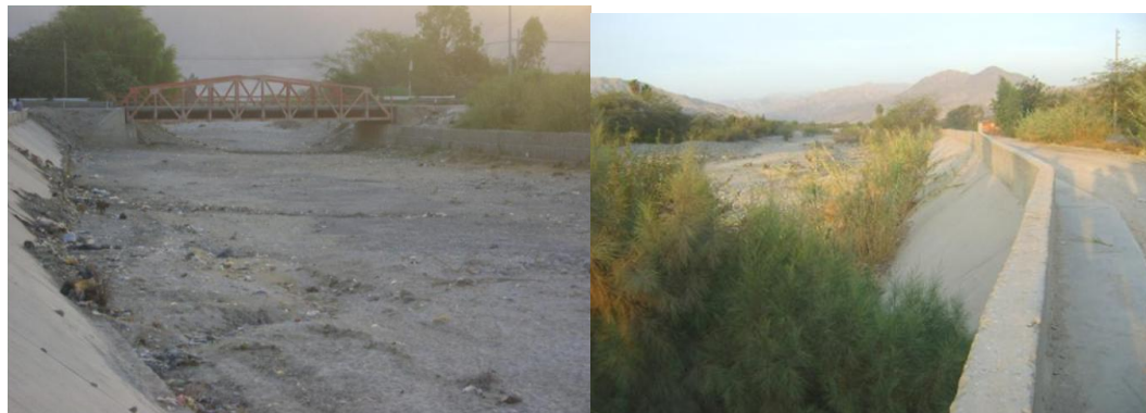
En las dos imágenes se muestra el cauce del río Palpa. Izquierda se muestra el río a la altura del puente vehicular de la Panamericana, con limpieza y descolmatación (buen estado de mantenimiento). Derecha, se muestra el río Palpa a 1 Km aguas arriba del Puente, condiciones no adecuadas (lleno de vegetación, desmonte, basura, etc.)
