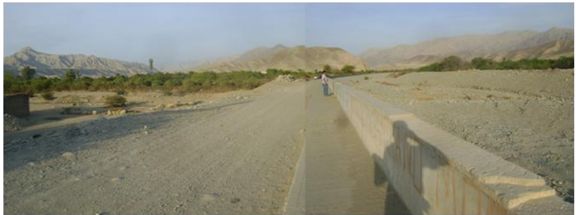
La fotografía corresponde a la zona sur de la Ciudad de Palpa, hacia la derecha se muestra el río Viscas y a la izquierda asentamiento humanos de la ciudad, como se puede apreciar la topografía del asentamiento es menor a la topografía del cauce. En esta zona se produjo la inundación del año 1972. Se muestra también el muro de protección y encauzamiento del río Viscas.
