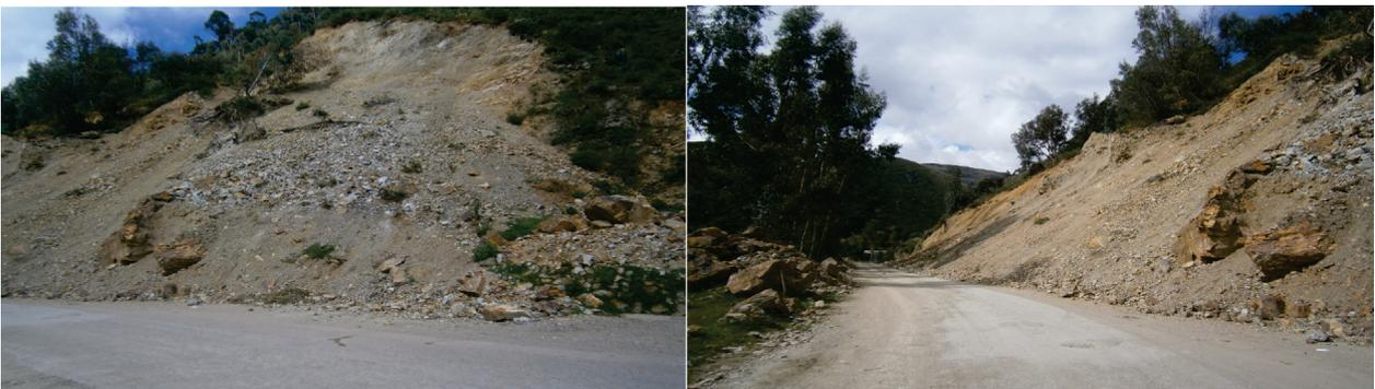
**Fotografía 6.3** Derrumbes en talud superior de la carretera Ingenio-Ranra.
