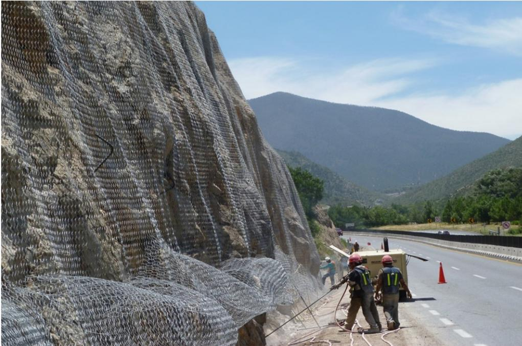
**Fotografía 8.2** Mallas de protección con anclajes para caída de rocas o derrumbes tanto en detritos como roca alterada.
