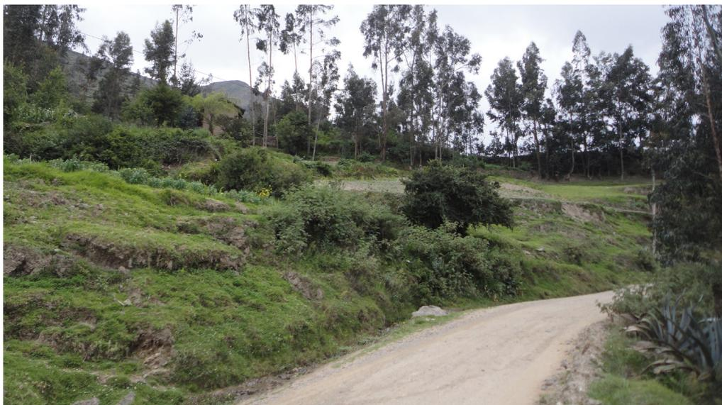
**Fotografía 6.7** Deslizamiento rotacional reactivado en el Cerro Rargapunta, sector de Huasahuasi; para estabilizar su avance han sembrado árboles de eucaliptos.
