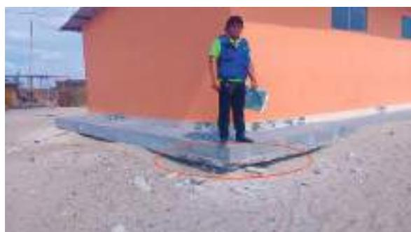
Aula con sistema constructivo Drywall con techo a dos aguas y cobertura de fibrocemento. Piso de concreto suspendido en el aire por erosión en el suelo de soporte efecto de fuertes vientos en la zona.
