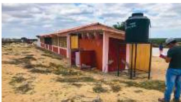
Aulas de albañilería confinada con pisos de concreto, techo a dos aguas con tijerales metálicos, correas de madera, cobertura de fibrocemento. Canaletas para drenaje pluvial sin tubería bajante y cunetas, para evacuación de agua, vulnerable a inundación por lluvias.
