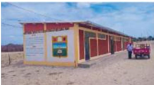
I.E. N° 20099 Letigio. Se aprecia irregularidad vertical "efecto de columna corta". Canaletas para drenaje pluvial con ausencia de tubería bajante y cunetas de concreto en el perímetro que complementen el sistema siendo vulnerable a inundación por lluvias. Falta cerco perimétrico para seguridad.
