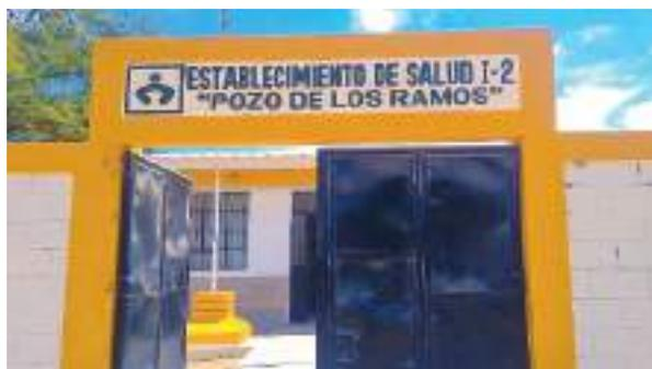
El establecimiento de Pozo de los Ramos, tiene techo con cobertura de calaminón, dispone de tanque elevado de forma rectangular. La construcción tiene el efecto de columna corta en ambientes.
