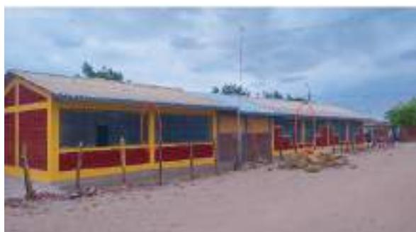
I.E. N°15333 "Zona More". Aulas de albañilería confinada con techo a dos aguas y cobertura de fibrocemento. Se aprecia irregularidad vertical "efecto de columna corta" parte posterior de dichas aulas por ventanales.
