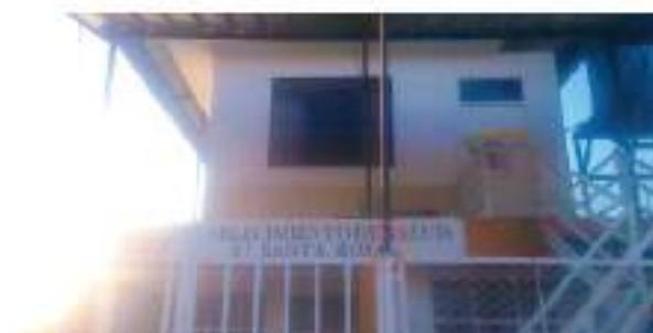
Establecimiento Santa Rosa, techo soportado por perfiles tubulares a su vez apoyados sobre los postes del cerco metálico y en las columnas de confinamiento del primer nivel, los perfiles de soporte no cuentan con arriostramiento. Existe posibilidad que un movimiento sísmico provoque un desplazamiento del techo y su colapso.
