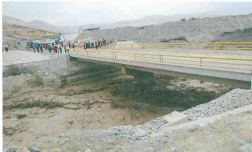
Puente sobre el llamado "Río Seco", en el Sector del Cerro Arunta en el Distrito de Gregorio Albarracín, observamos el proceso de erosión a los pilares del puente.
